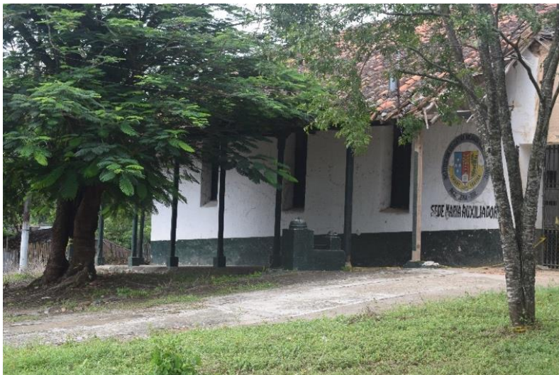
Figura 29 Fotografía del estado actual de la Factoría. Fuente: Fuente: propia, 2021
