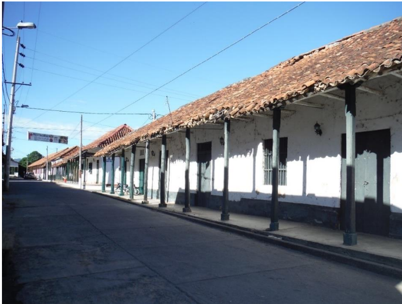
Figura 3. Ambalema y sus columnas. Fuente: Elaboración Propia. 2020
