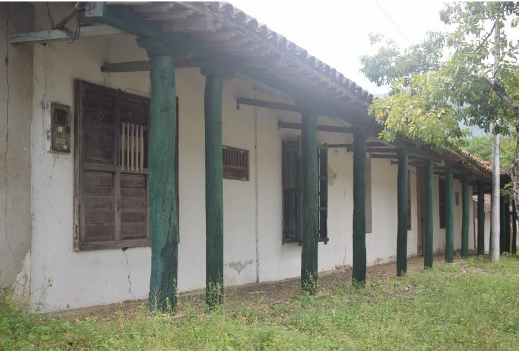
Figura 28 La casona. Fuente: Elaboración propia 2020.
