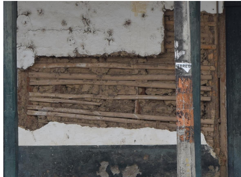
Figura 10 Muro de Bahareque. Fuente: propia 2020.
