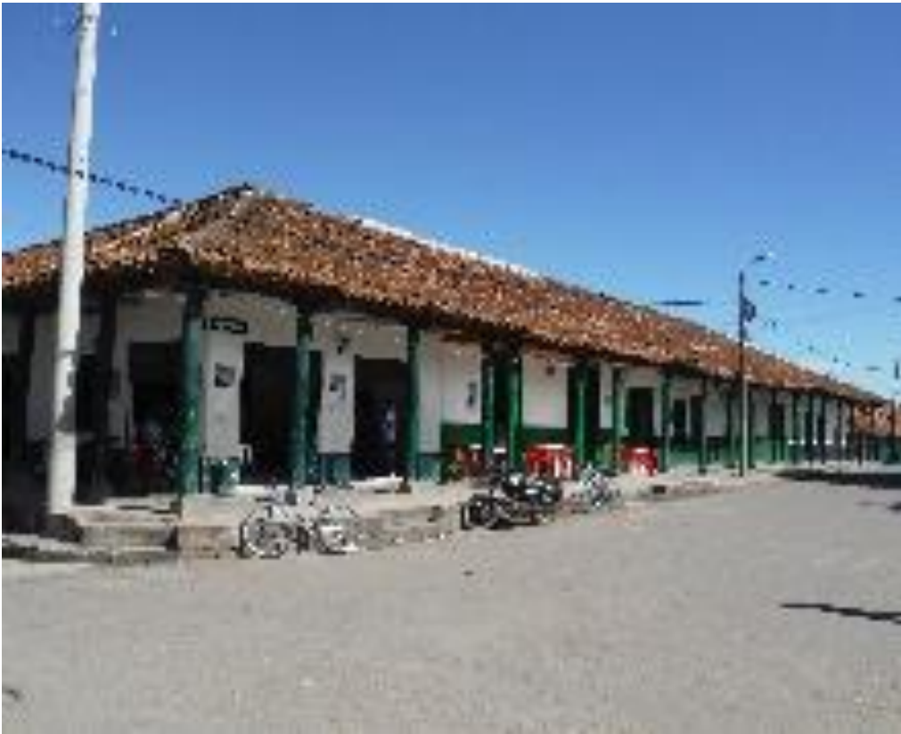
Figura 12 Columnas y. Fuente: propia 2020.
