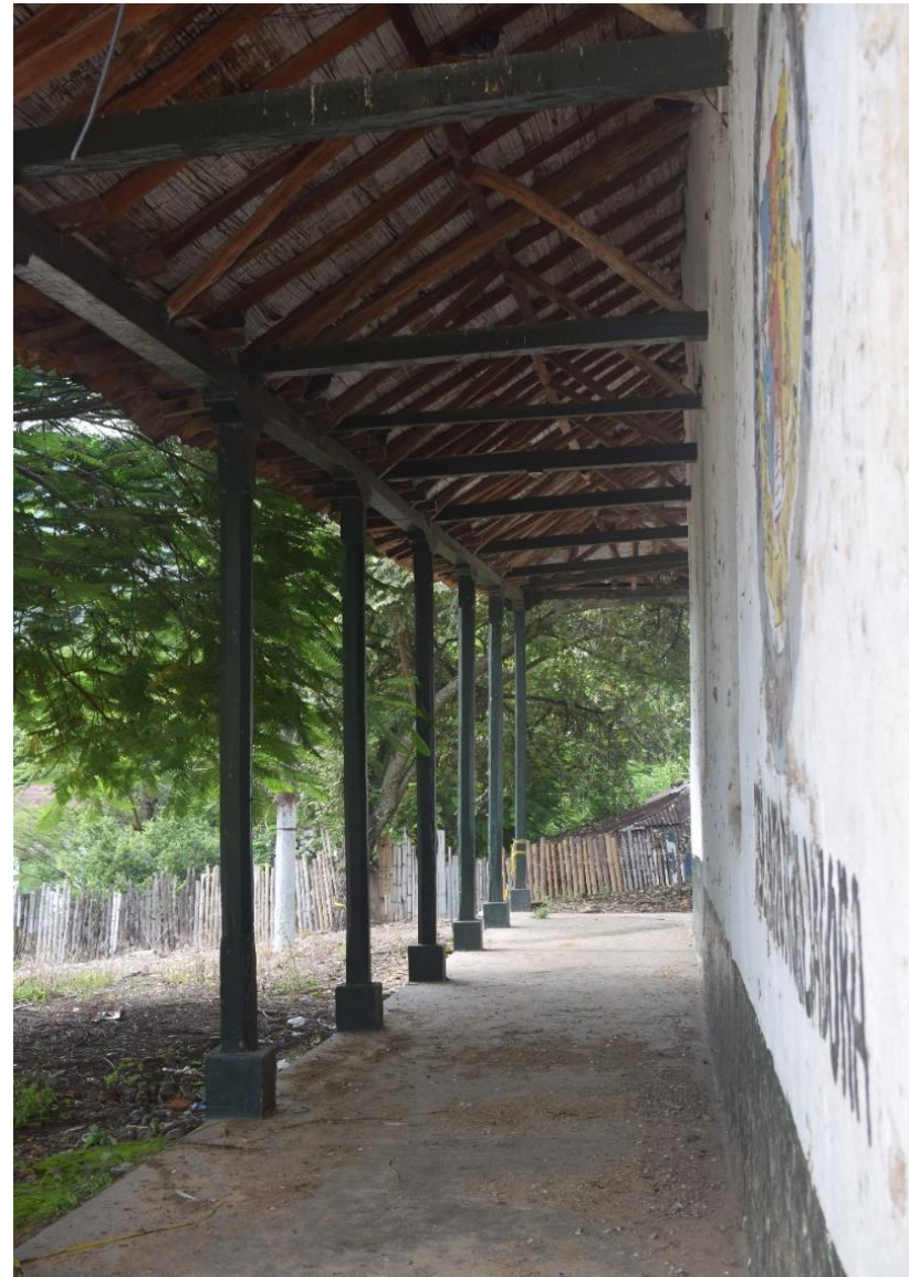
Figura 11 Cubierta de par y nudillo. Fuente: propia 2020.
