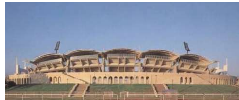
Figura 87. Imágen exterior tras la remodelación
