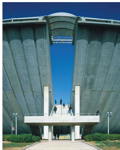
Figura 14. Imágen exterior de las escaleras en las separaciones de las gradas
