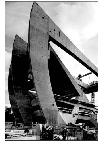
Figura 80. Imagen de la construcción del estadio en 1971
