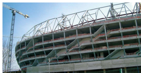
Figura 169. Imágen del proceso de construcción
