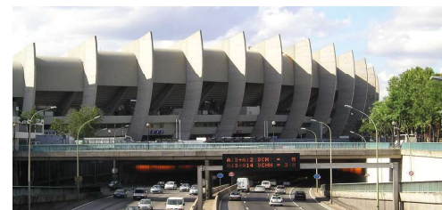
Figura 79. Imagen exterior del estadio sobre el paso de la circunvalación
