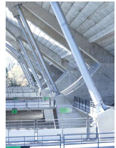
Figura 110. Imagen de la estructura de las nuevas gradas
