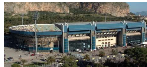
Figura 50. Vista exterior de la fachada principal
