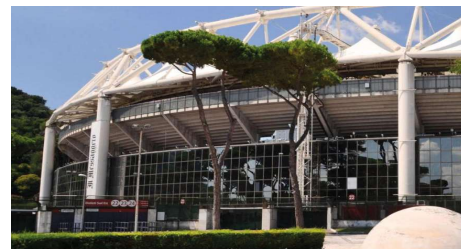
Figura 55. Vista exterior de la fachada
