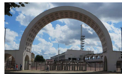
Figura 104. Arco monumental de acceso
