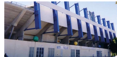
Figura 108. Imagen exterior, con la estructura de la ampliación a la izquierda
