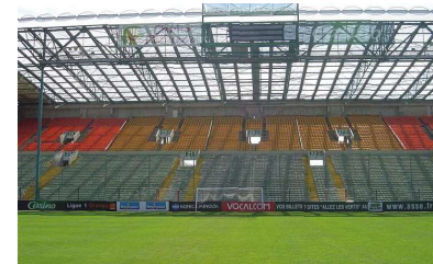
Figura 113. Cubierta sur con plexiglás
