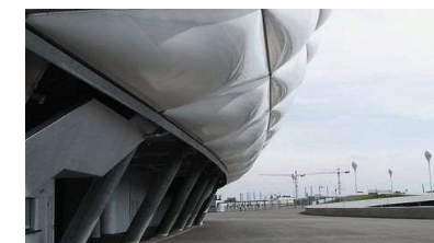
Figura 171. Vista de los alledaños del estadio
