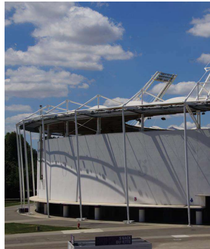
Figura 92. Imágen exterior tras la remodelación
