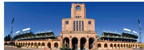
Figura 21. Fachada principal tras la ampliación
