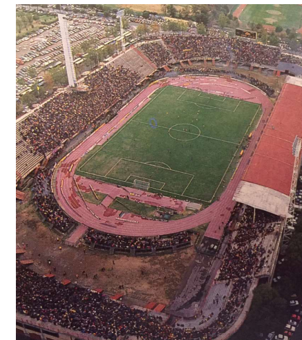
Figura 32. Imagen del estadio antes de la remodelación de 1987
