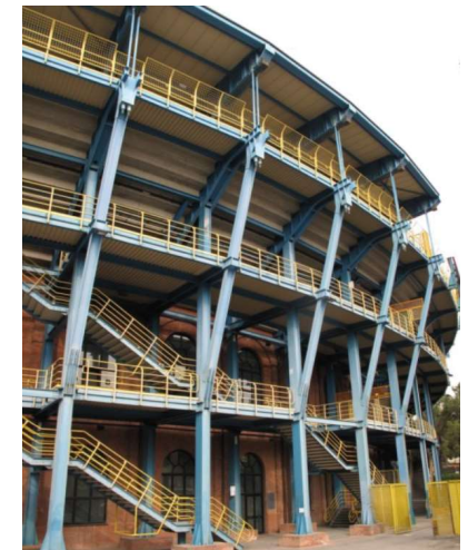
Figura 22. Imagen exterior con la ampliación
