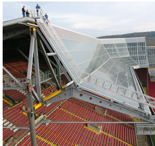
Figura 122. Imagen de la construcción de la cubierta
