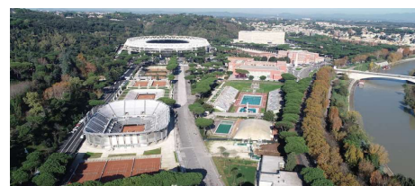
Figura 56. Imagen aérea del Foro Itálico
