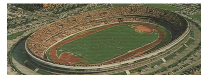
Figura 69. Imágen previa a la remodelación
