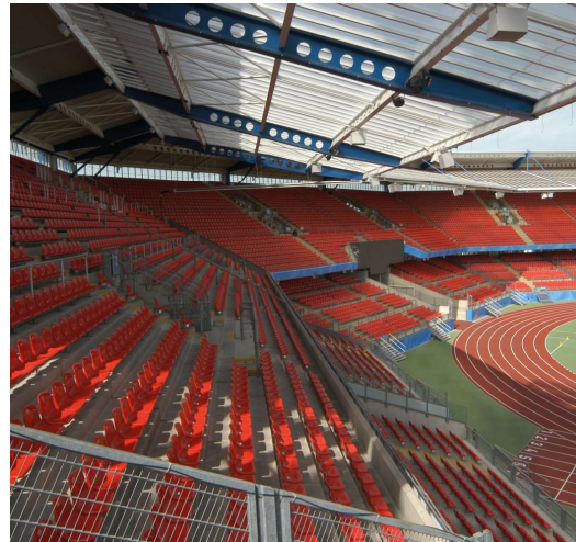
Figura 127. Imagen interior bajo la cubierta
