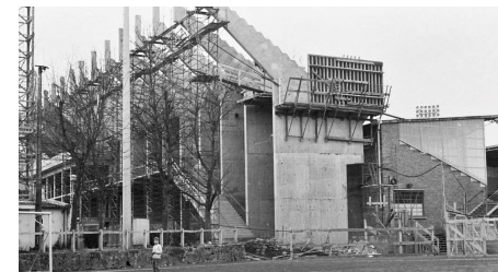
Figura 119. Construcción de la tribuna norte en 1982
