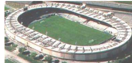
Figura 93. Imágen previa a la remodelación
