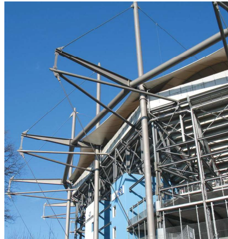
Figura 153. Imágen del exterior con los soportes de la cubierta
