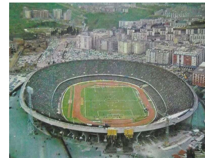
Figura 45. Imagen aérea previa a la reforma
