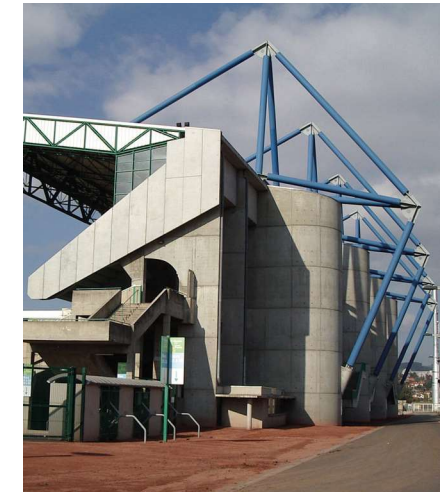
Figura 115. Imagen de la estructura de las nuevas gradas
