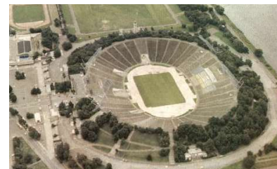
Figura 134. Vista aérea del estadio anterior, demolido en el año 2000
