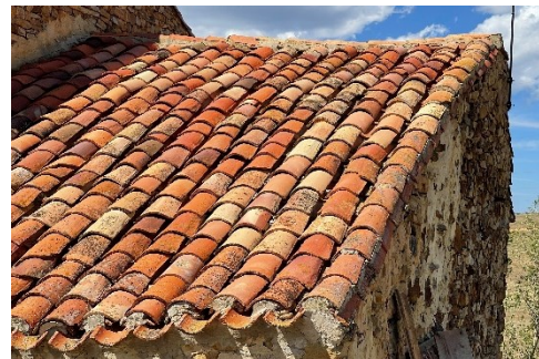
Imagen 23. Cubierta de teja. Las Aldehuelas, Soria. Fuente: E.P. (2022)
