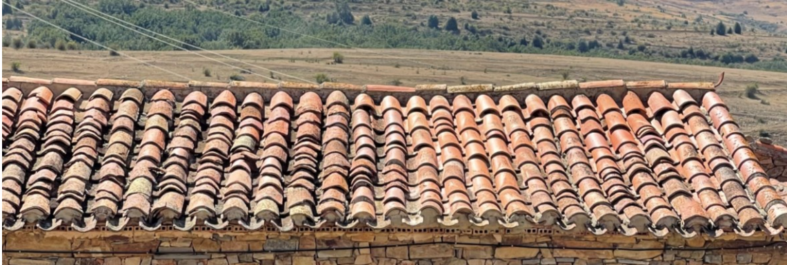
Imagen 14. Cubierta de teja doble en Las Aldehuelas, Soria. Fuente: Elaboración propia (2022)
