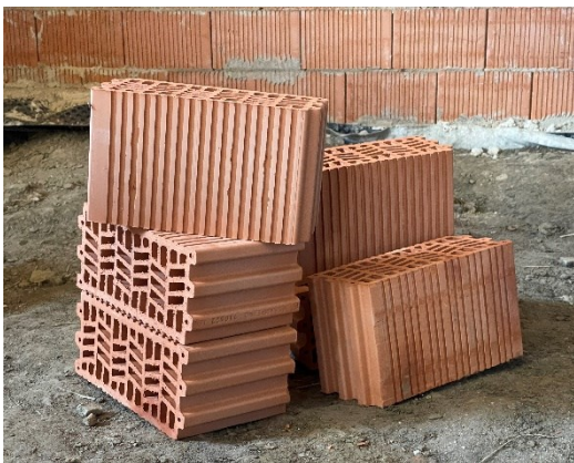
Imagen 48. Trasdoso de termoarcilla, Soria. Fuente: Elaboración propia. (2022)
