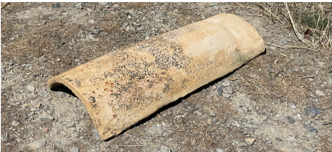
Imagen 15. Teja curva realizada de forma manual. Las Aldehuelas, Soria. Fuente: Elaboración propia (2022)
