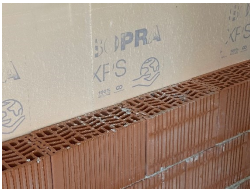
Imagen 77. Termoarcilla con A.T. (XPS), Soria. Fuente: Elaboración propia. (2022)
