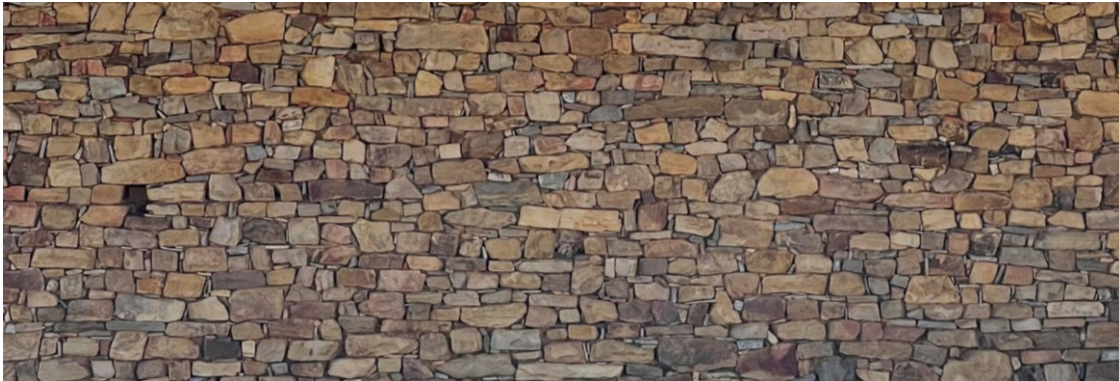
Imagen 18. Muro de piedra en Las Aldehuelas, Soria. Fuente: Elaboración propia (2022)
