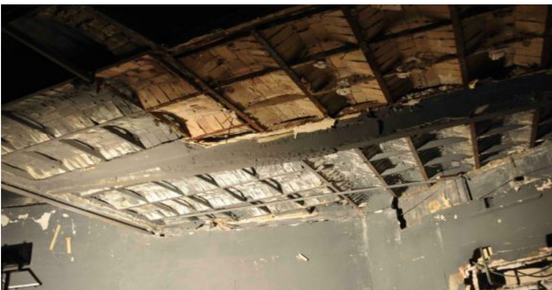
56. Estado actual del forjado de entreplanta de la sala de cine
