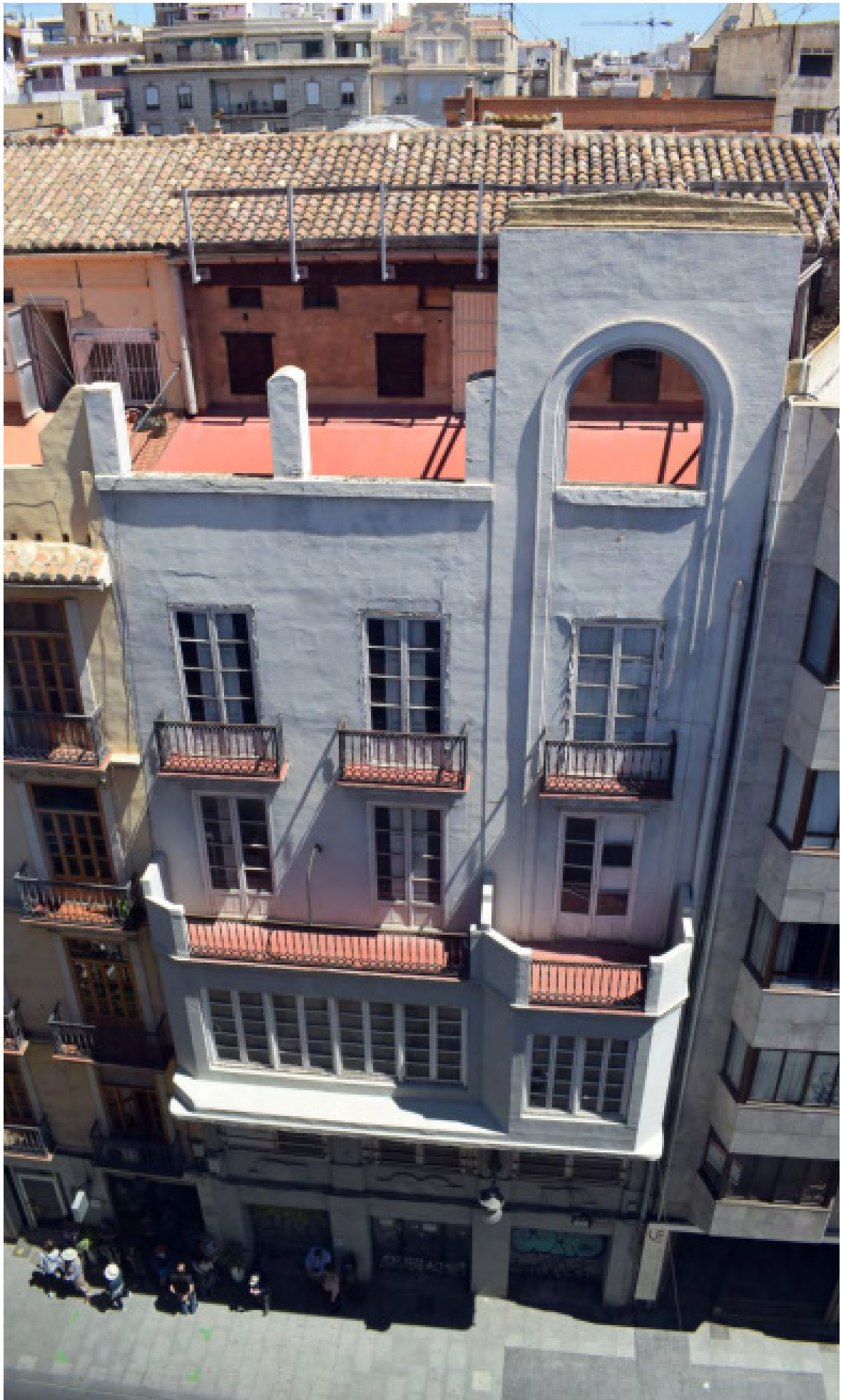
53. Vista aérea del edificio, fotografía del informe en defensa del Metropol de la Universitat de València
