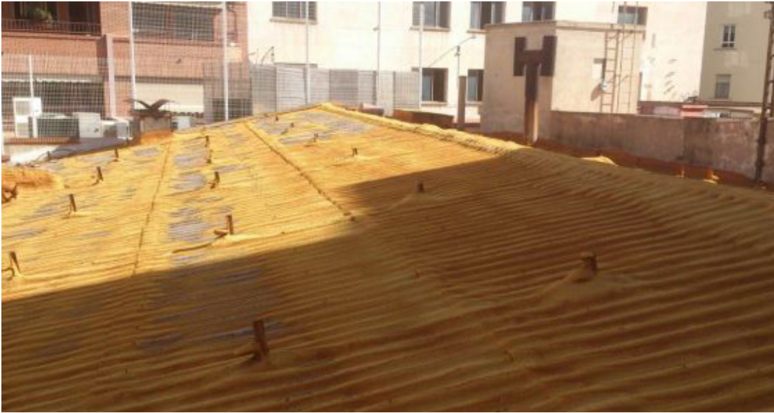
56. Foto de la cubierta del cine Metropol
