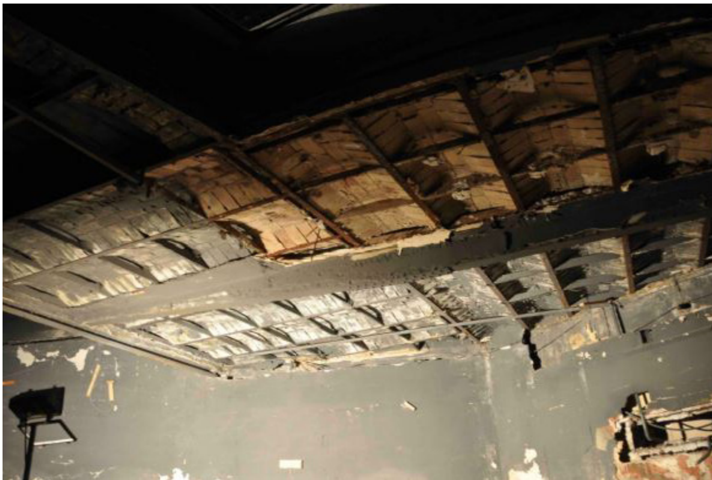
103. Estado actual del forjado de entreplanta de la sala de cine
