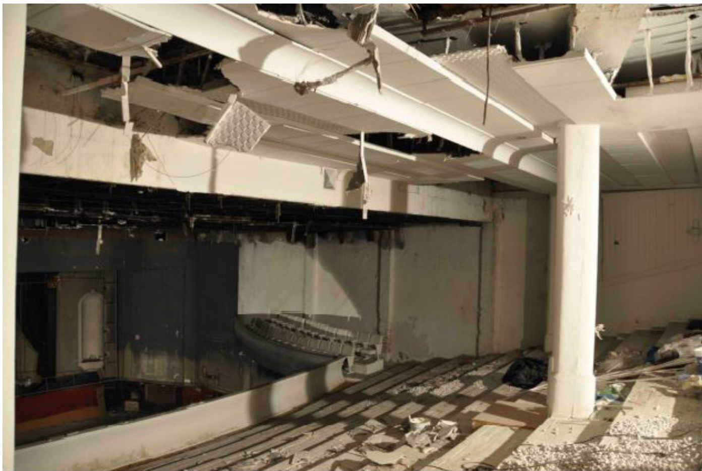
105. Estado actual sala a nivel de entreplanta
