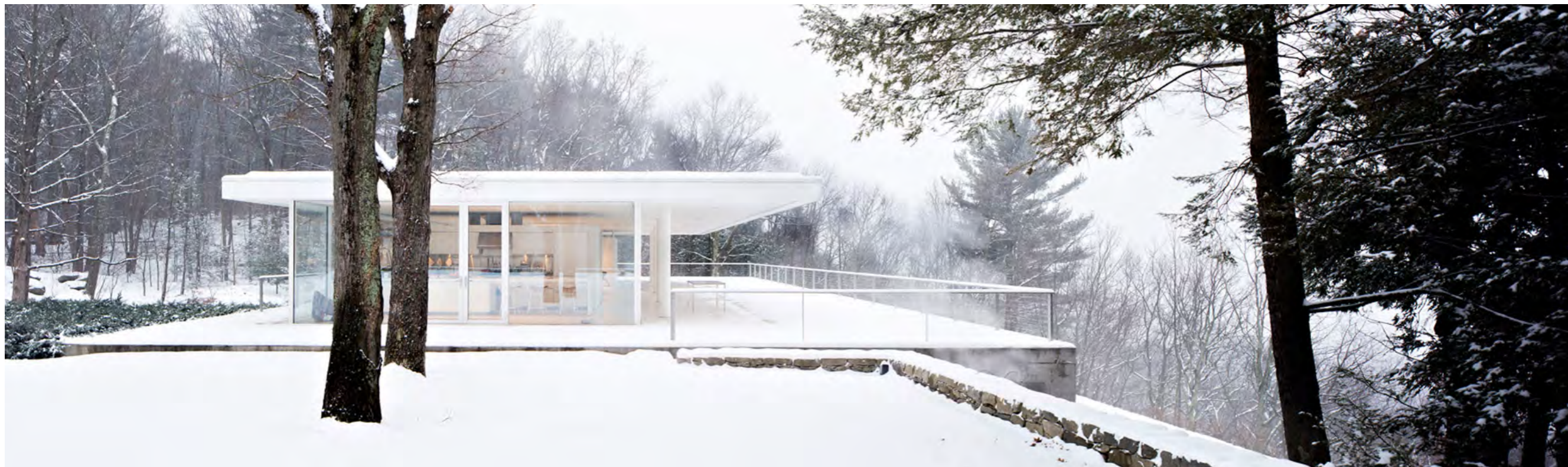
Fig 21: Casa Olnick Spanu. Fotografia exterior.
