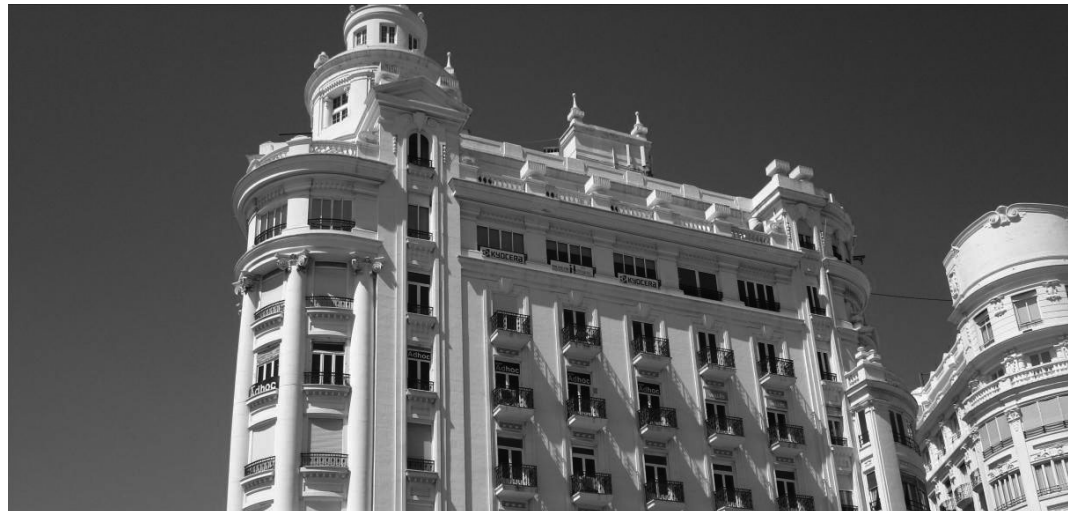
Fig.11. Edificio Barrachina, Javier Goerlich Lleó, 1930. Fuente: jdiezarnal.com
