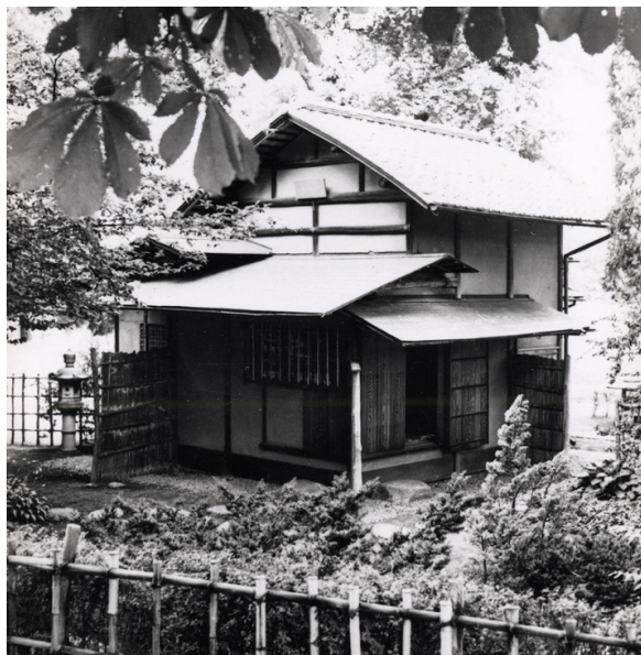
Fig. 28. Pabellón Zui-ki-tei original (1935), destruido por un incendio en 1969.
