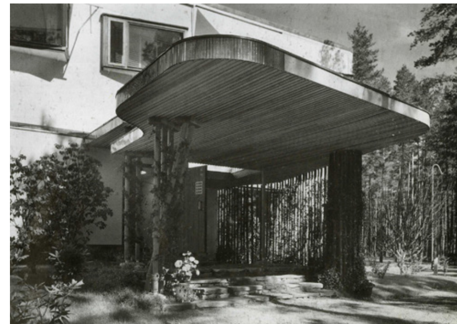
Fig. 40. Marquesina de entrada y pantalla de finos troncos verticales.
