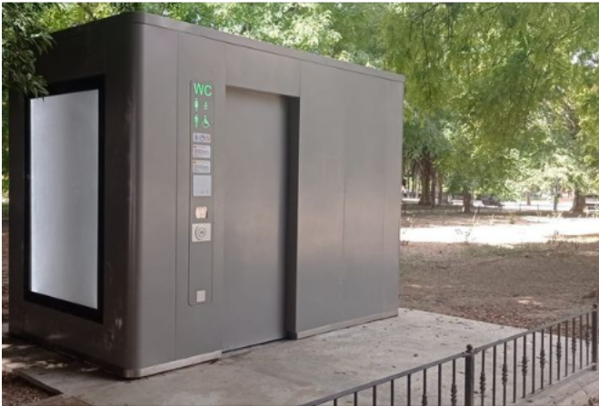
Fig_17. Publicación del alcalde de València sobre la instalación de un baño autolimpiable. 2022.
