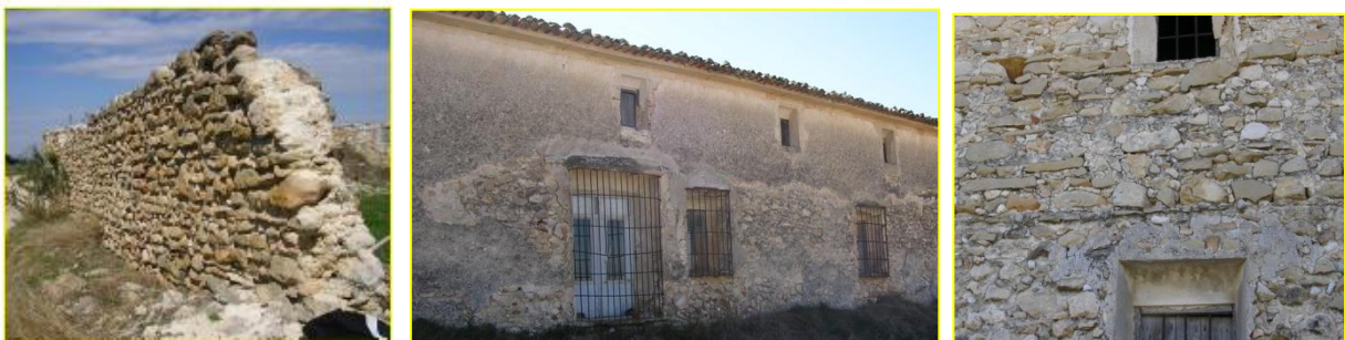
Figura 13: Murs de maçoneria
