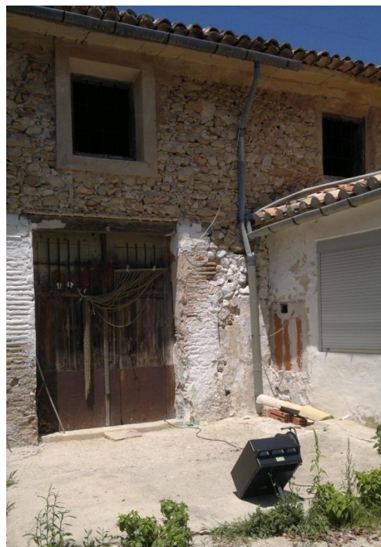
Figura 5. Muntatge de l'equip. Vista des del pati interior
