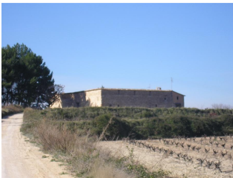
Figura 3 Vistes des del Sud-Est
