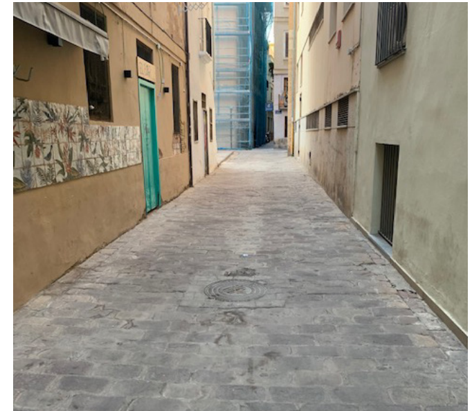
Calle En Pina dirección Corretgeria. Adoquinado de rodено sin aceras. Fotografía propia.
