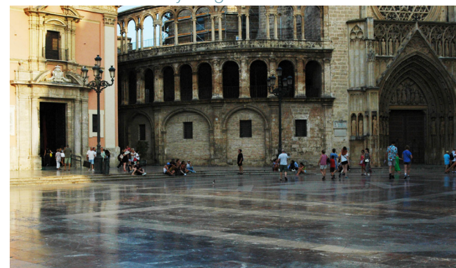
Pavimentación actual realizada en piezas de caliza marmórea de distinto formato. Fotografía propia.
