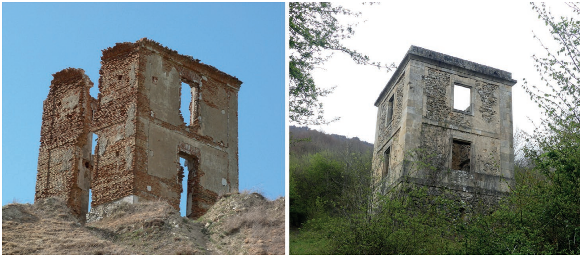
Figura 9. Imágenes de las torres de telégrafo en su estado actual. A la izquierda, la torre de Tariego (Palencia), y a la derecha, la torre de Basaleku (Alsasua, Navarra).
