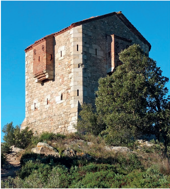
Figura 4. Torres exentas de Vauban. A la izquierda, la torre de Panissars asociada al fuerte de Bellegarde; a la derecha, la torre de la Redoute Béar en Port-Vendres.
