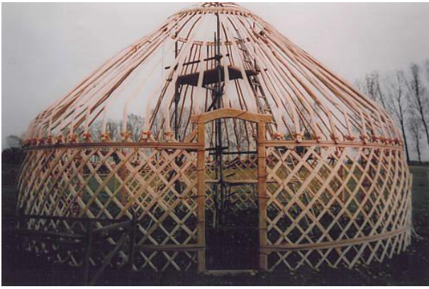
FIGURA 17. Esqueleto de madera de una yurta
