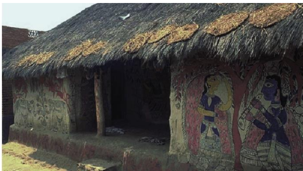
FIGURA 14. Antigua vivienda con pinturas Mithila
