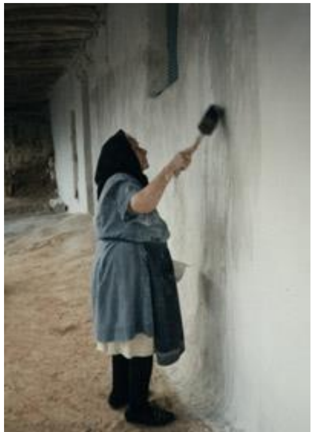
FIGURA 34. Jalbegando (encalando) una pared de los soportales
