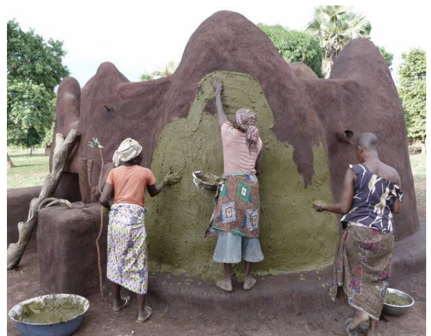
FIGURA 9. Aplicación del adobe para posterior colocación de la cubierta
