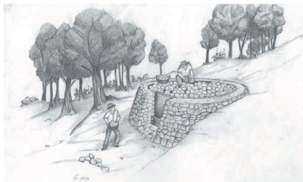
FIGURA 30. Formación de un horno de cal
