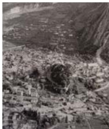
121_Foto tomada después del terremoto de Septiembre
