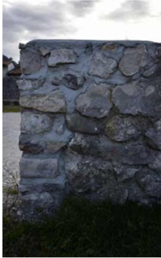
56_Señalización mediante distinción de morteros
