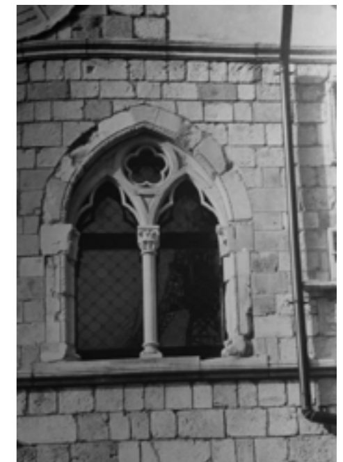
92_Detalle de la ventana después de la restauración
