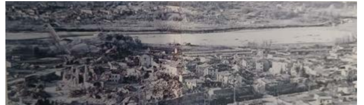
143_Foto tomada después del terremoto de Septiembre
