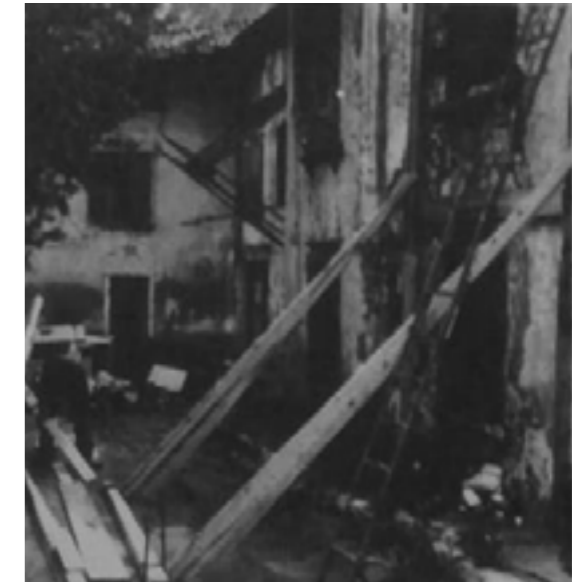
84_Foto del edificio después del terremoto del 15 de septiembre
