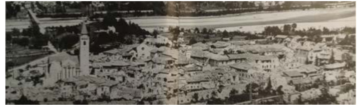
142_Foto tomada después del terremoto de Mayo
