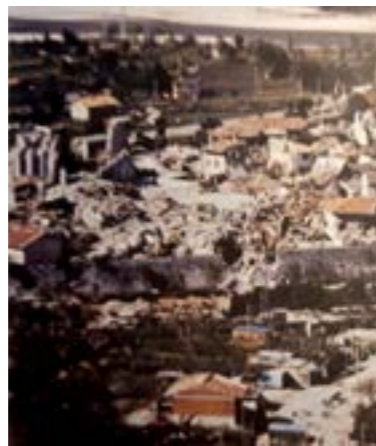
118_Foto tomada después del terremoto de Septiembre
