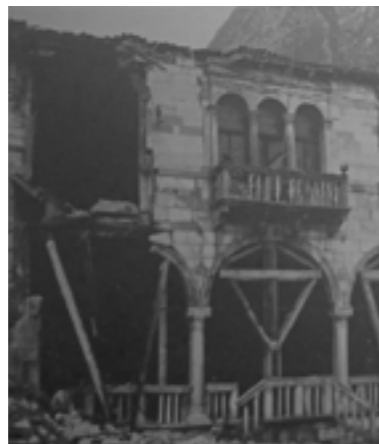
136_Foto tomada después del terremoto de Septiembre
