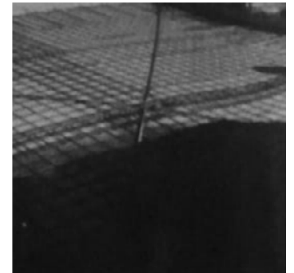
86_Foto de la rehabilitación del forjado de la primera planta
