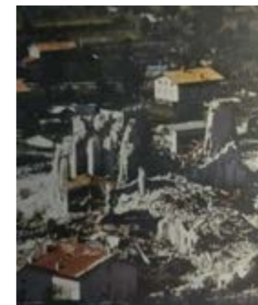
130_Foto tomada después del terremoto de Septiembre
