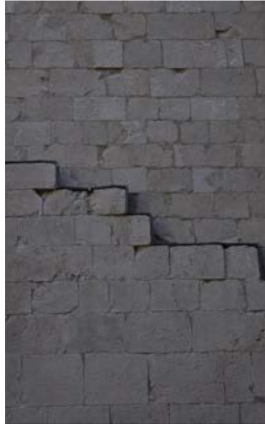
57_Señalización mediante desfase de sillares
