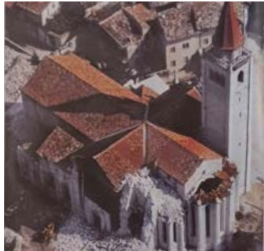
95_Foto del Duomo después del terremoto de mayo
