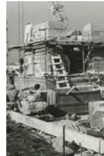
47_Foto del desmonte en Egipto del templo
