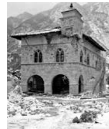
127_Foto tomada después del terremoto de Mayo
