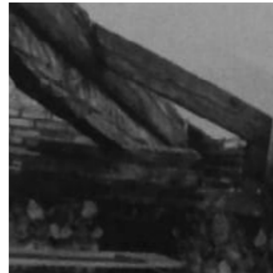
85_Foto de la rehabilitación de las vigas de madera históricas
