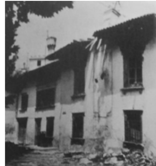
83_Foto del edificio después del terremoto del 6 de mayo
