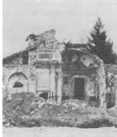
133_Foto tomada después del terremoto de Septiembre
