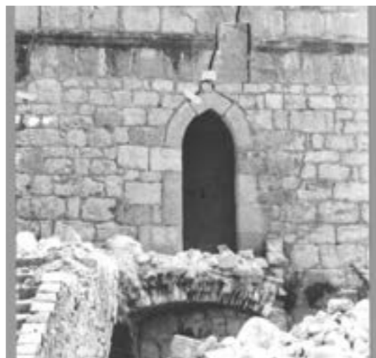
114_Detalle del Campanile después del terremoto de septiembre
