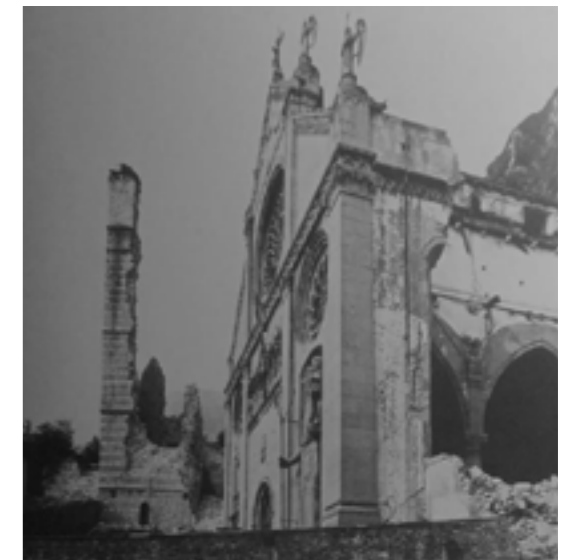
110_Foto del Duomo después del terremoto de mayo
