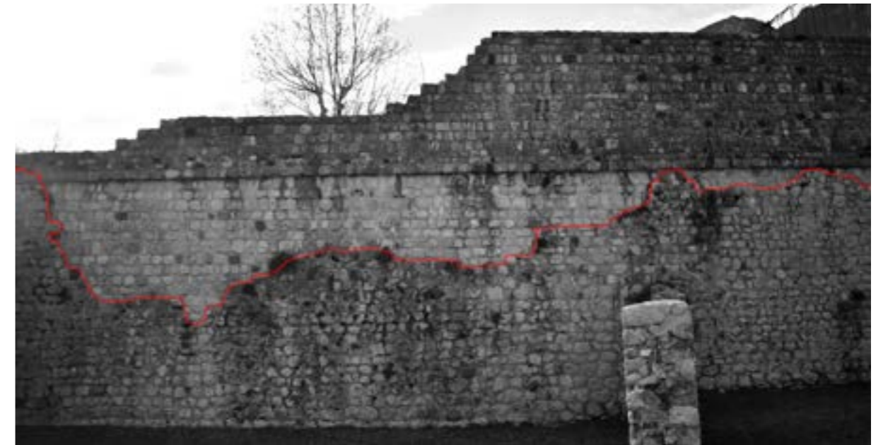
54_Foto de la muralla Oeste de Venzone, diferenciación del material mediante diferencia de color de sillar
