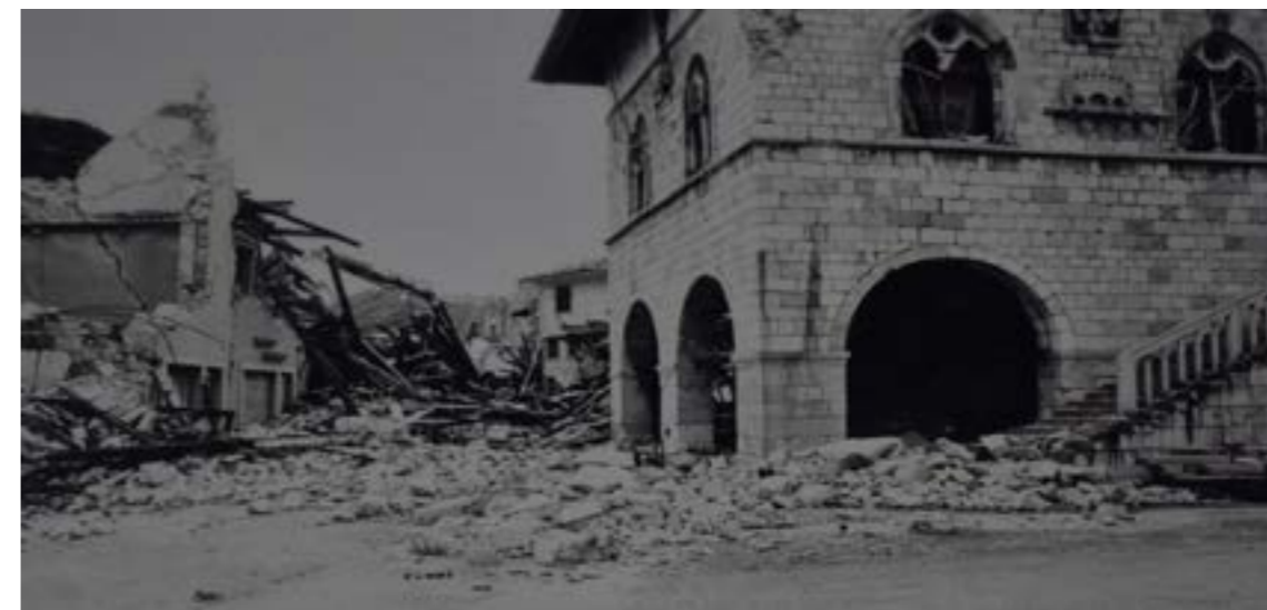
31_Foto de Piazza Municipio, Venzone, después del terremoto
