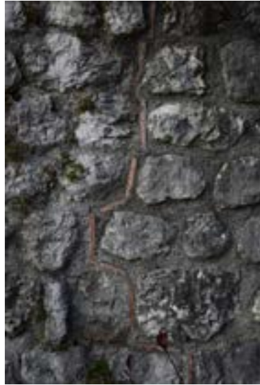
51_Señalización mediante baldosas cerámicas
