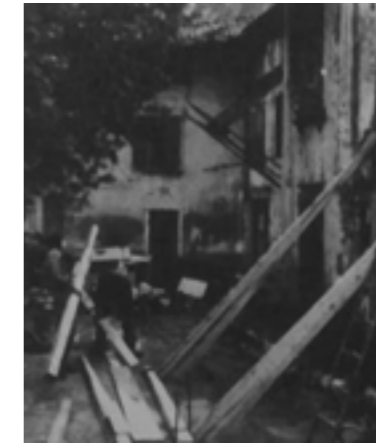
124_Foto tomada después del terremoto de Septiembre
