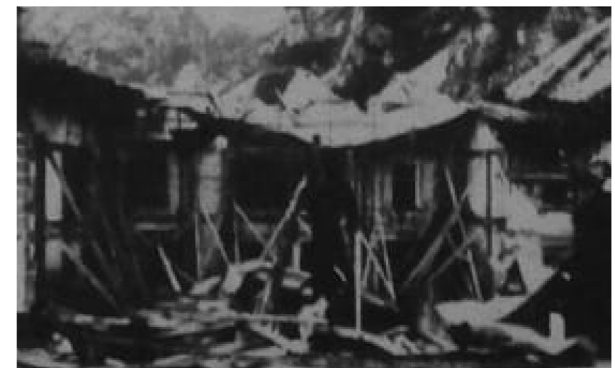
87_Foto de los inicios de las obras
