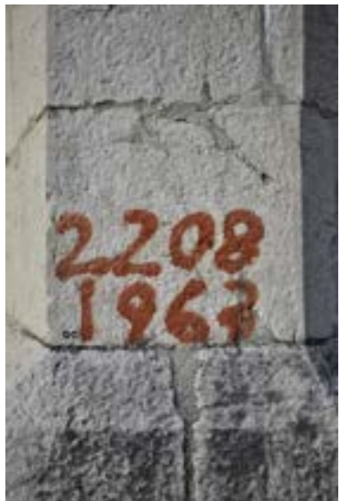
52_Señalización mediante números
