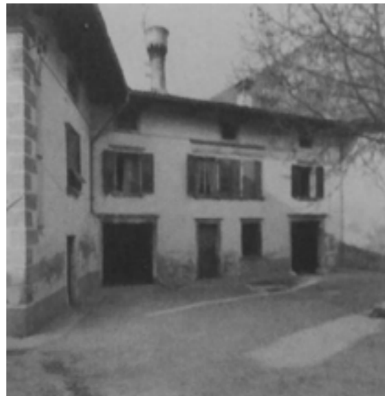
82_Foto del edificio antes del terremoto
