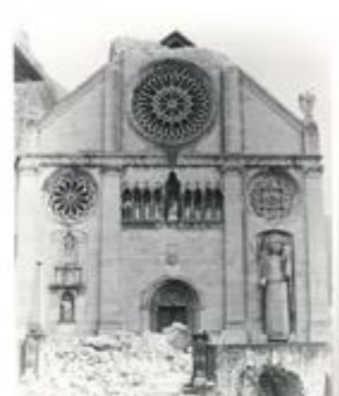
139_Foto tomada después del terremoto de Septiembre
