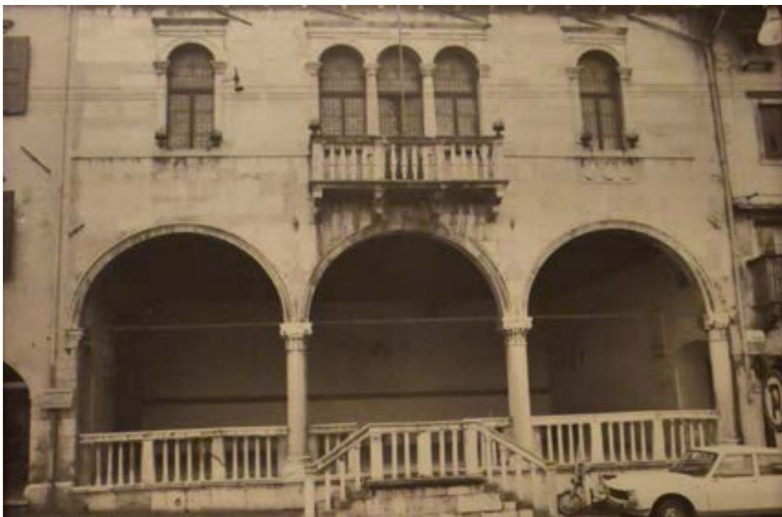
36_ Foto de Piazza del Municipio, Gemona, antes del terremoto
