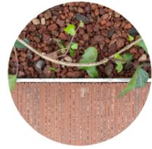
Adoquín de cerámica de bajo valor comercial como material reciclado de pavimento permeable
