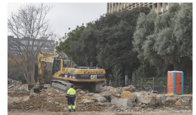
Obras de ampliación del Clínico el pasado día 15. Iván Arlandas
