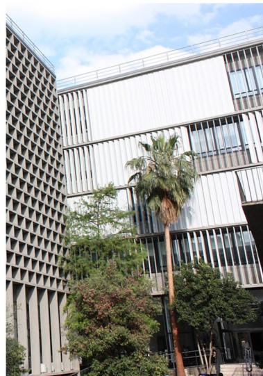
Brise-Soleil proyectado para las fachadas a oeste
