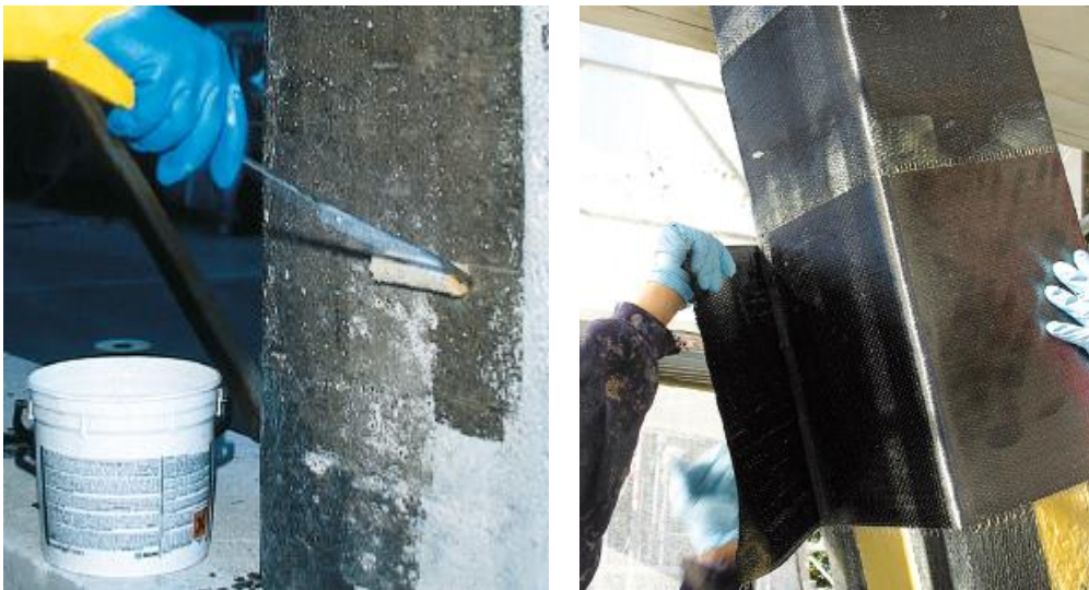
Figura 58: Imprimació i aplicació del teixit en reforç de pilars [25]
