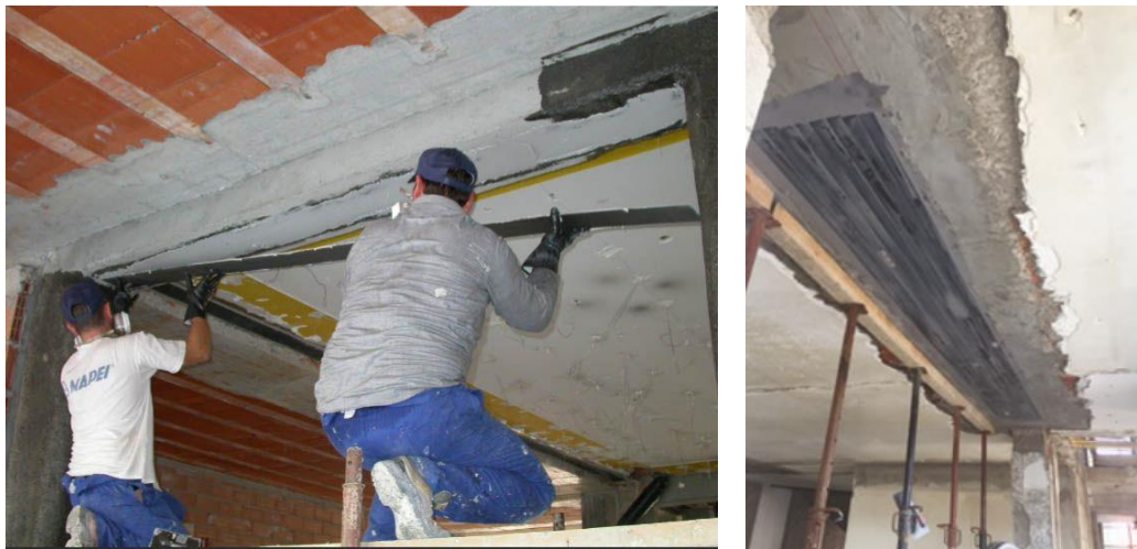
Figura 56: Aplicació de l'adhesiu i reforç de bigues planes [27]
