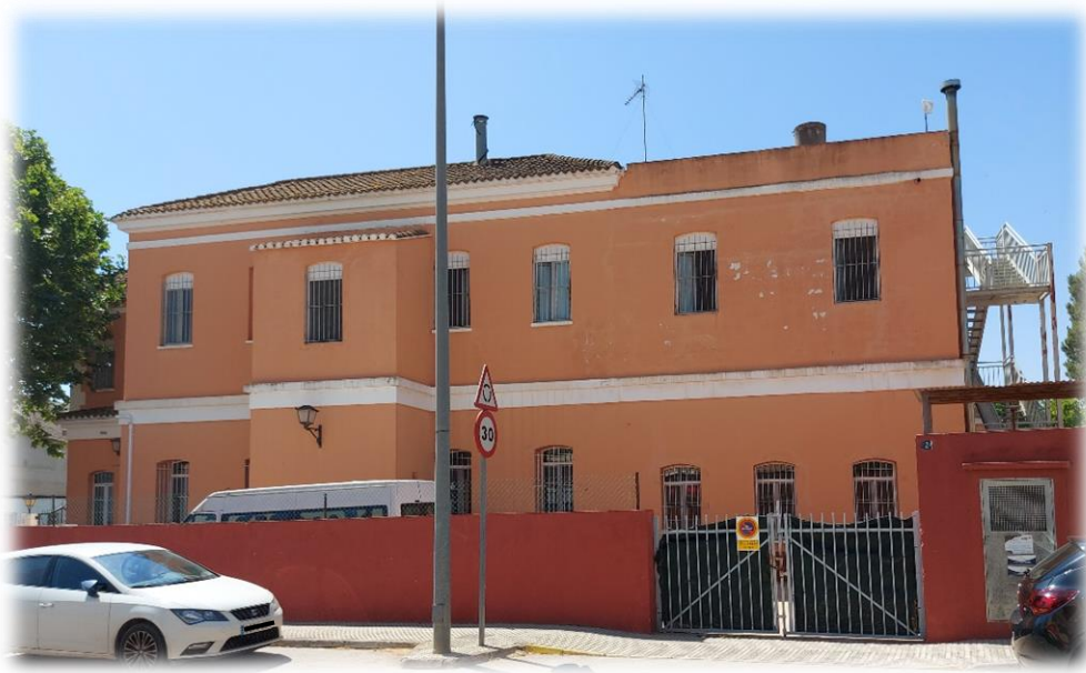
Figura 15: Façana lateral (Autoria pròpia)
