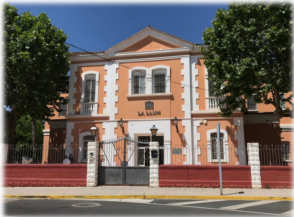
Figura 14: Façana principal (Autoria pròpia)
