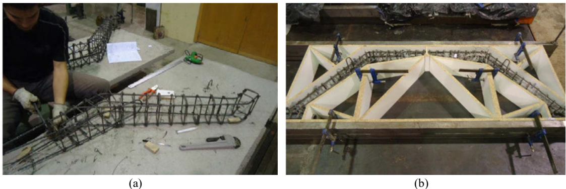
Fig. 5. Fotografías del trabajo en laboratorio (Ciurana, 2014; Rueda-García, 2014): (a) Montaje y atado de la armadura; (b) Colocación de la ferralla en el encofrado.
