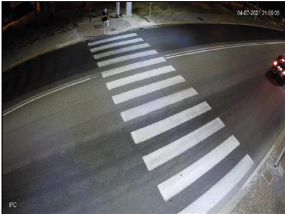
Figura 66: Falta de activación del sistema de iluminación por fallo del sensor de movimiento. Fuente: Facoltà d'Ingenieria di Bologna
