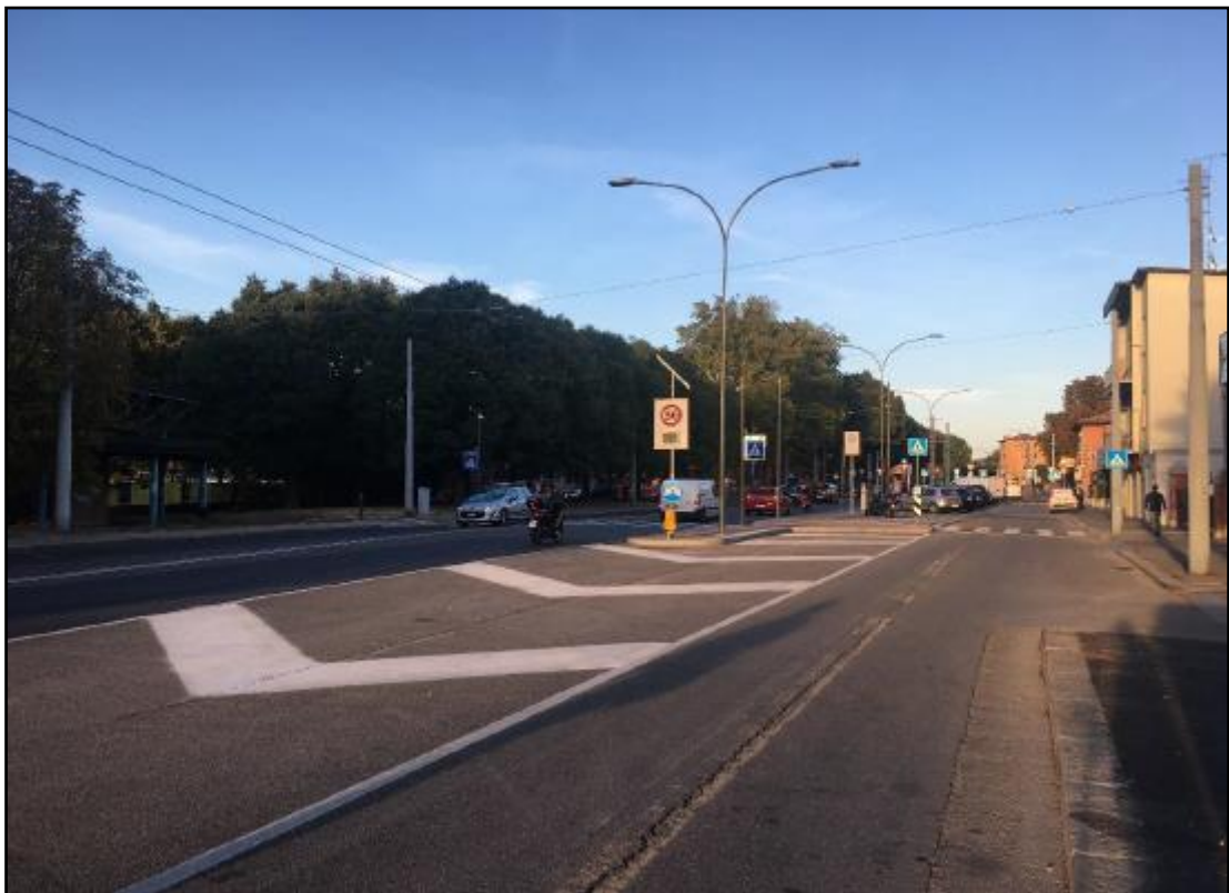
Figura 8: Fotografía del paso de peatones. Fuente: Elaboración propia
