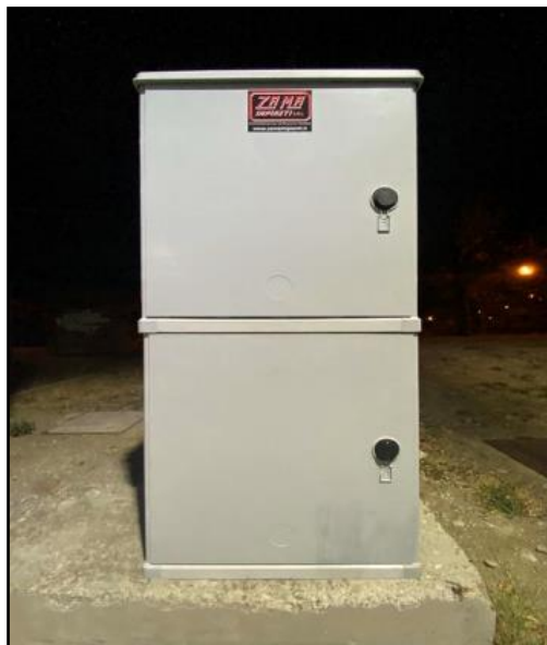
Figura 38: Caja de control de iluminación. Fuente: Facoltà d'Ingegneria dell'Università di Bologna
