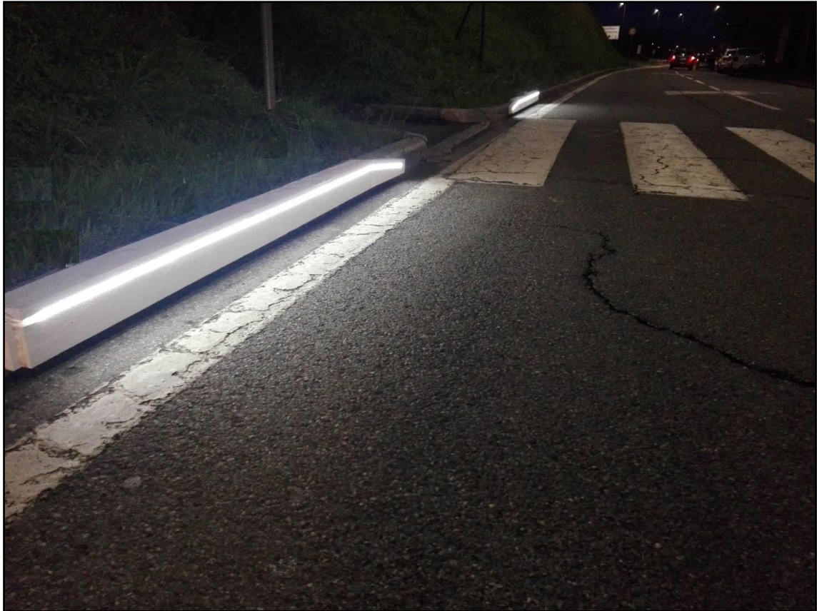
Figura 26: Sistema Lookatme en estado de prueba en Bologna. Fuente: http://www.zamaimpianti.it/
