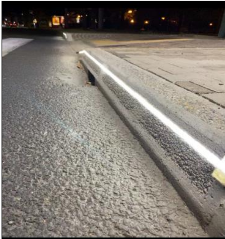
Figura 23: Sistema de iluminación del bordillo encendido. Fuente: Facoltà d'Ingegneria dell'Università di Bologna
