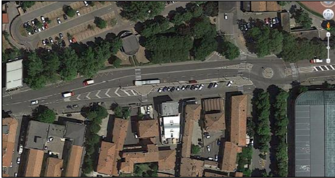
Figura 7: Vista cenital del paso de peatones objeto de estudio. Fuente: Elaboración propia
