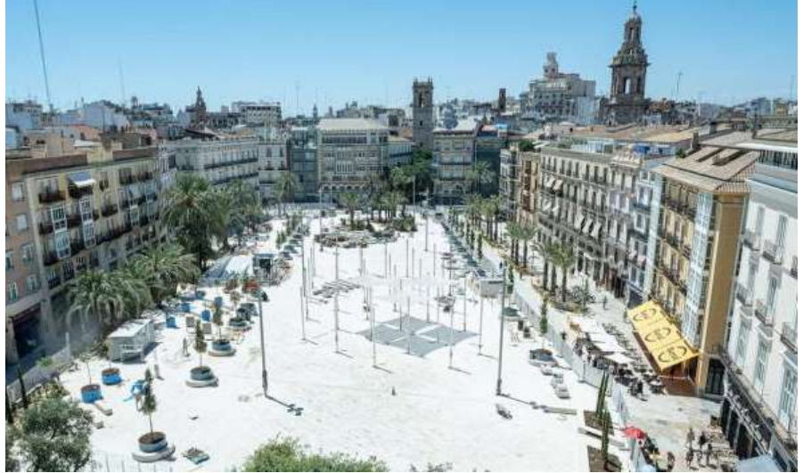
Fig. 67 Plaza de la reina antes de finalizar las obras
