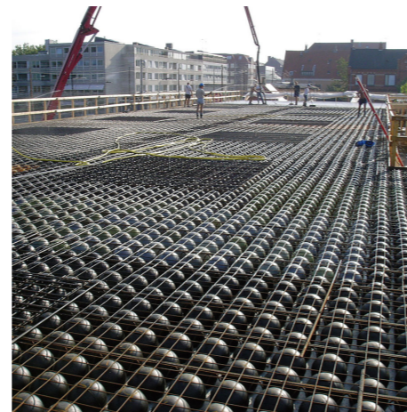
← F126 Forjado Bubble Deck.
