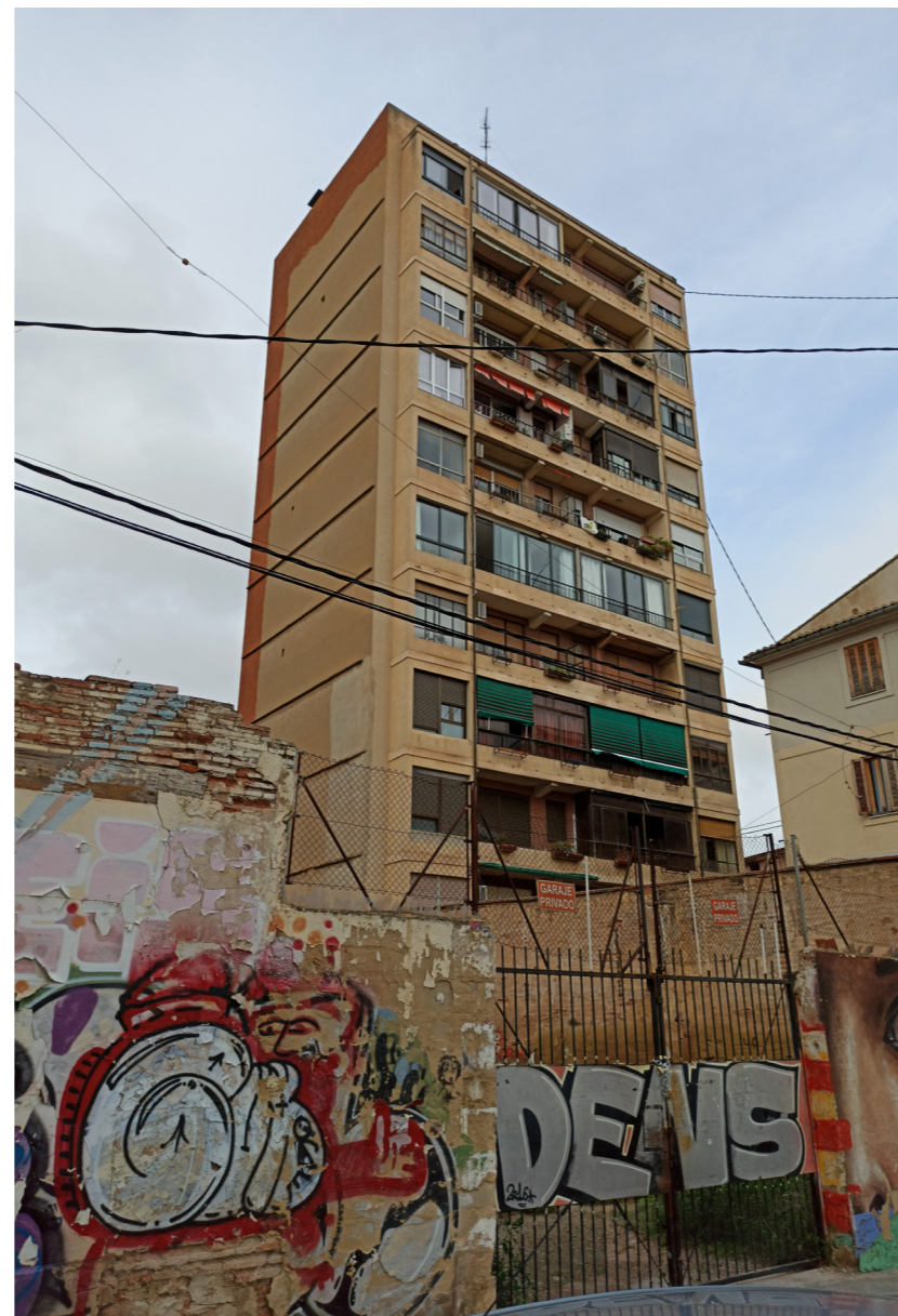
↑F8 Torre de viviendas de la calle Na Jordana. Fotografía: Daniel Javier Navarro
