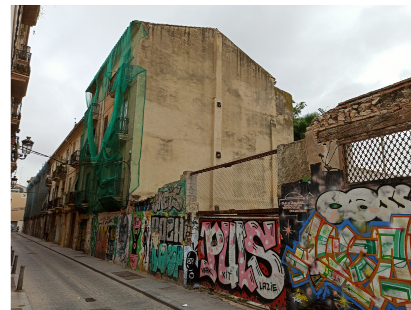
↑F7 Edificaciones de la calle Liria. Fotografía: Daniel Javier Navarro
