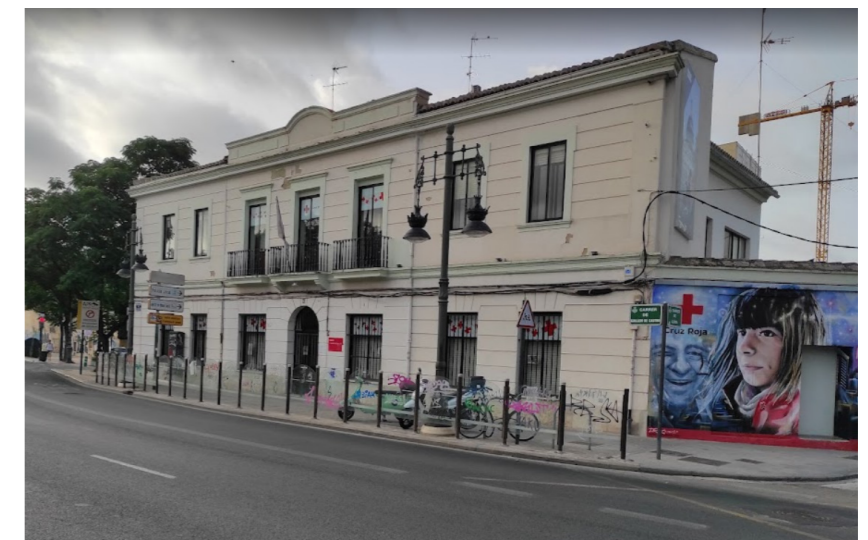
↑ F111 Sede de la Cruz Roja Valenciana. Fachada principal a Guillem de Castro. Fotografía: Daniel Javier Navarro
