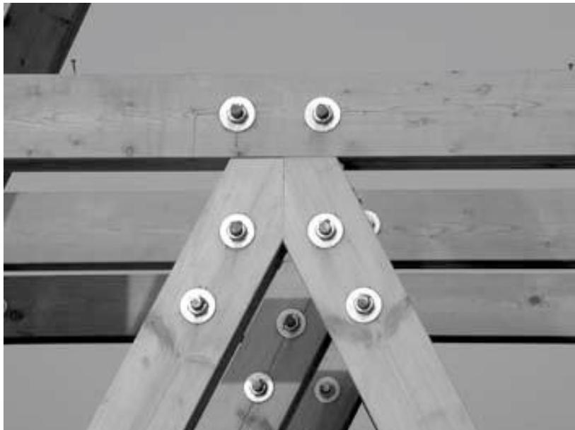
*Ilustración 14 Nudo de celosía con dos chapas y pernos de conexión*
