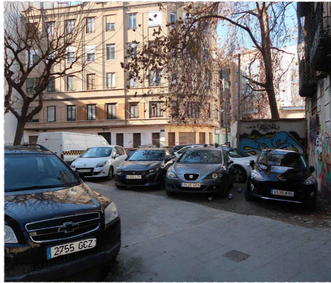
2_Edificio de la trama árabe
