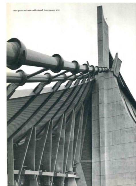
Fig. 81. Estructura de acero y hormigón del Nacional.
