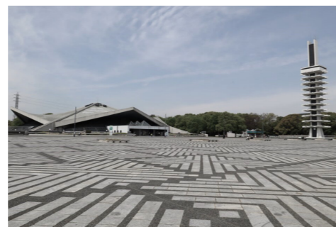
Fig. 64. Gimnasio de Komazawa y la Torre de Control.
