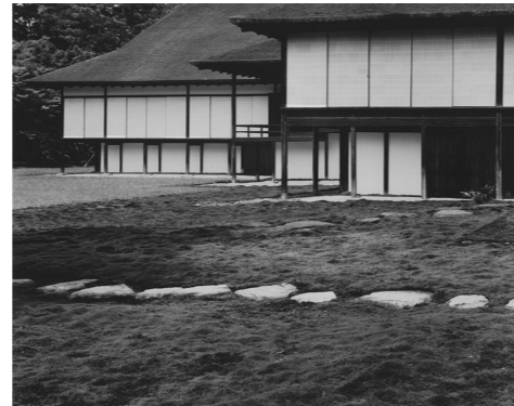
Fig. 18. Fachada exterior de la residencia imperial. Fotografiada por Ishimoto Yasuhiro
