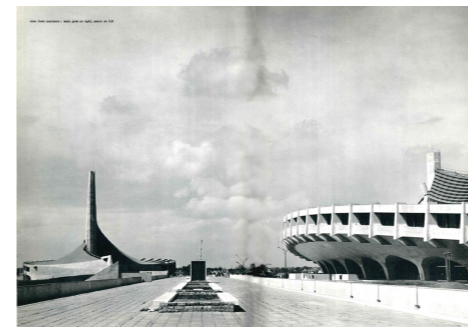
Fig. 78. Paseo peatonal Michikukan
