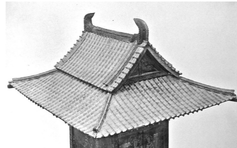
Fig. 11. Tipología cubierta irimoya-zukuri en detalle.
