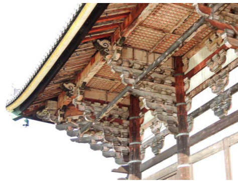
Fig. 15. Detalle del elemento estructural tokyo .
