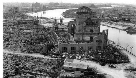
Fig. 27. La cúpula de Genbaku (actual monumento de la paz) después de la bomba nuclear en 1945.
