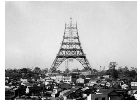
Fig. 35. La icónica Torre de Tokio en construcción.
