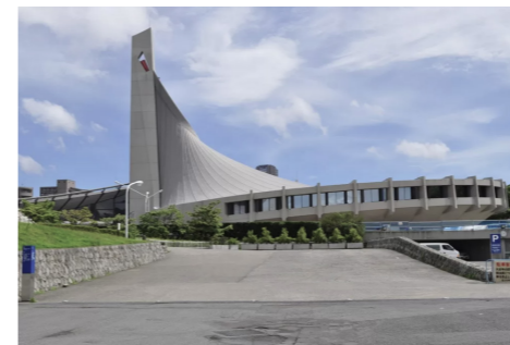
Fig. 57. Anexo al Gimnasio Nacional Yoyogi (Baloncesto).
