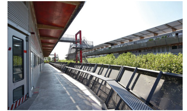
Fig. 92. Calle corredor junto con el banco corrido.
