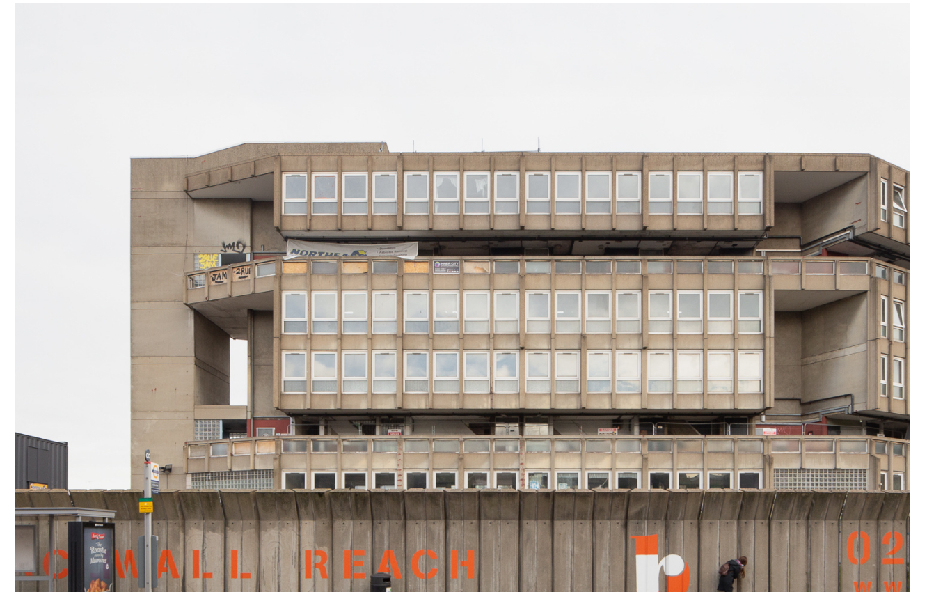
Fig. 81. Robin Hood Gardens previo de la demolición.
