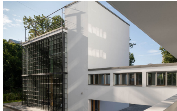
Fig. 42. Edificio anexo tras la restauración del edificio en 2020.
