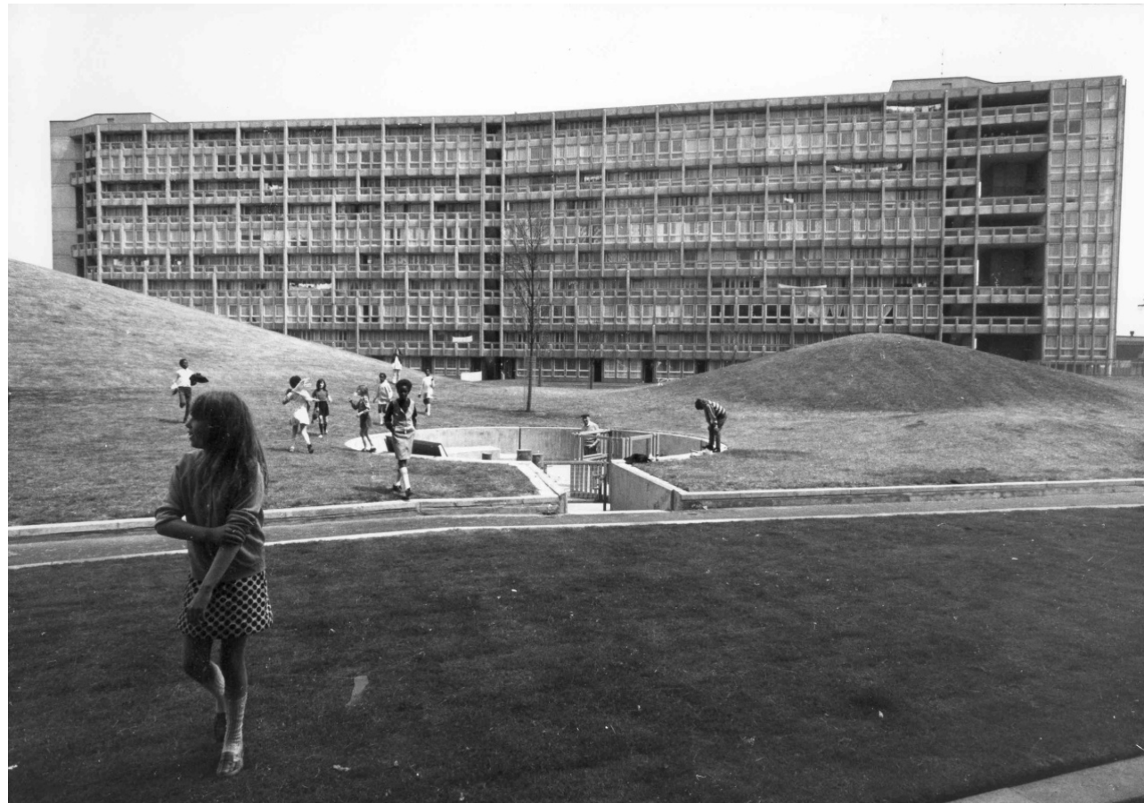
Fig. 74. Vista general del Robin Hood Gardens desde el interior.
