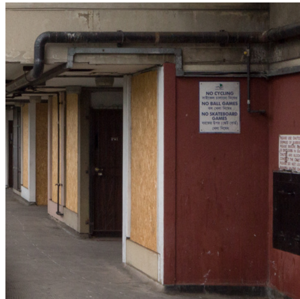
Fig. 80. Cartel posterior. Prohíbe jugar en el espacio común.
