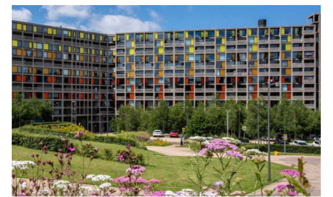
Fig. 73. Aspecto después de la restauración.
