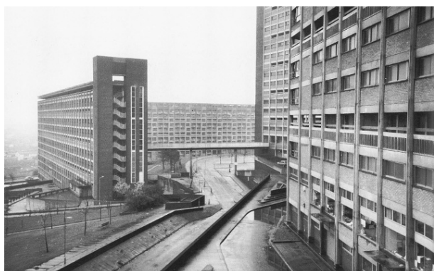
Fig. 64. Unión mediante un puente de la planta primera de un bloque con una planta intermedia del siguiente.
