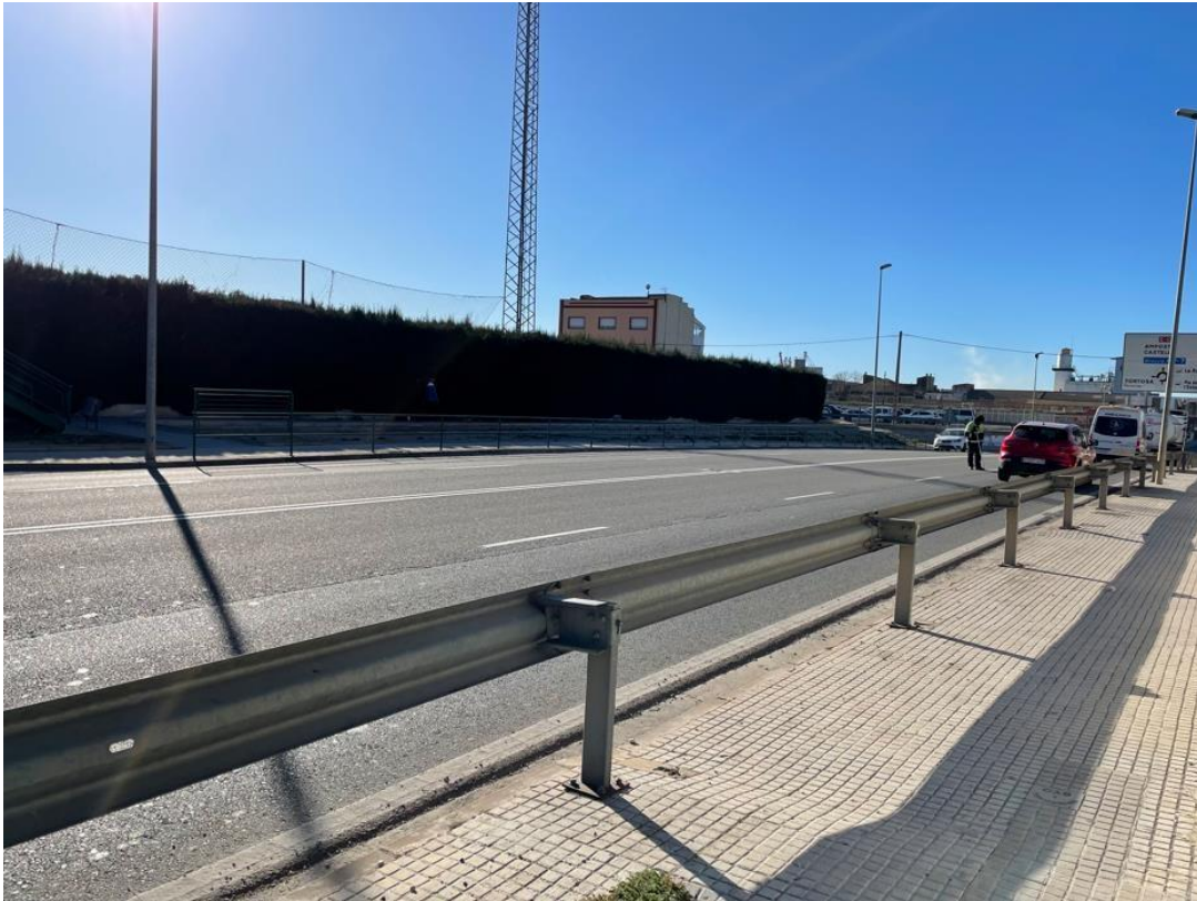
Figura 2. Visión general de la carretera C-12 en dirección sur del lado izquierdo de la calzada
