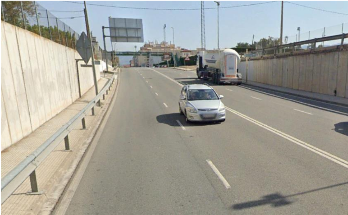
Figura 8. Visión desde abajo del puente que conecta con la Vías Verdes del Baix Ebre
