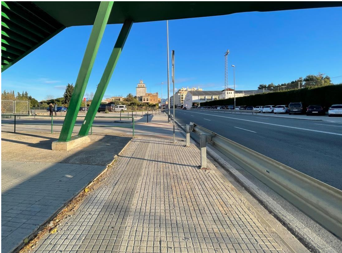
Figura 1. Visión general de la carretera C-12 en dirección noreste del lado izquierdo de la calzada
