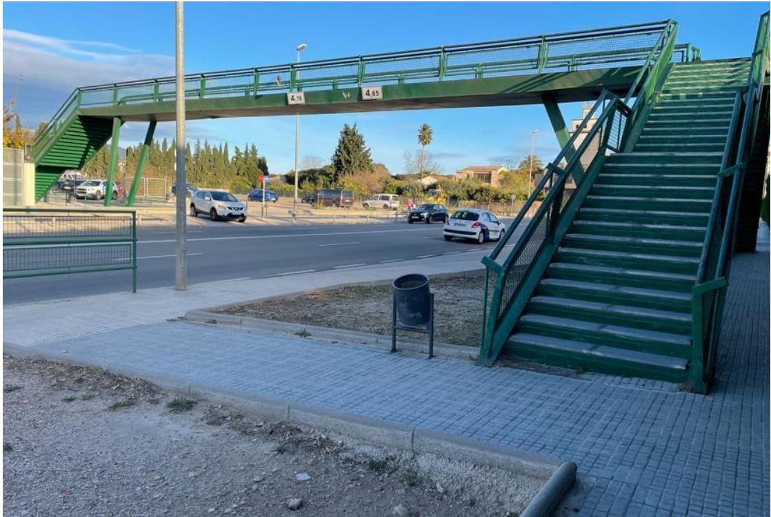
Figura 6. Visión general de la pasarela
