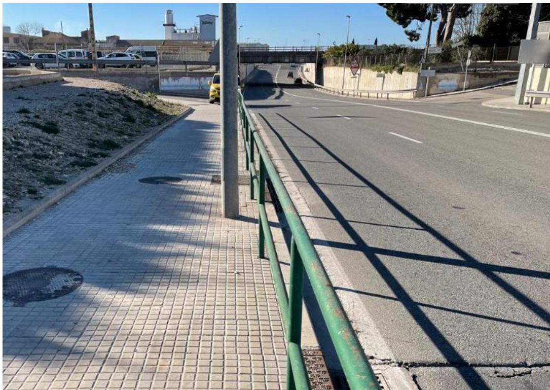
Figura 3. Visión del puente sobre la carretera C-12 del lado izquierdo de la calzada
