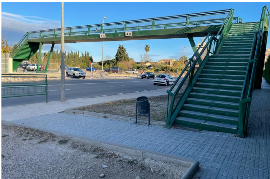
Figura 2. Fotografía de la pasarela en dirección (Fuente: Elaboración propia)
