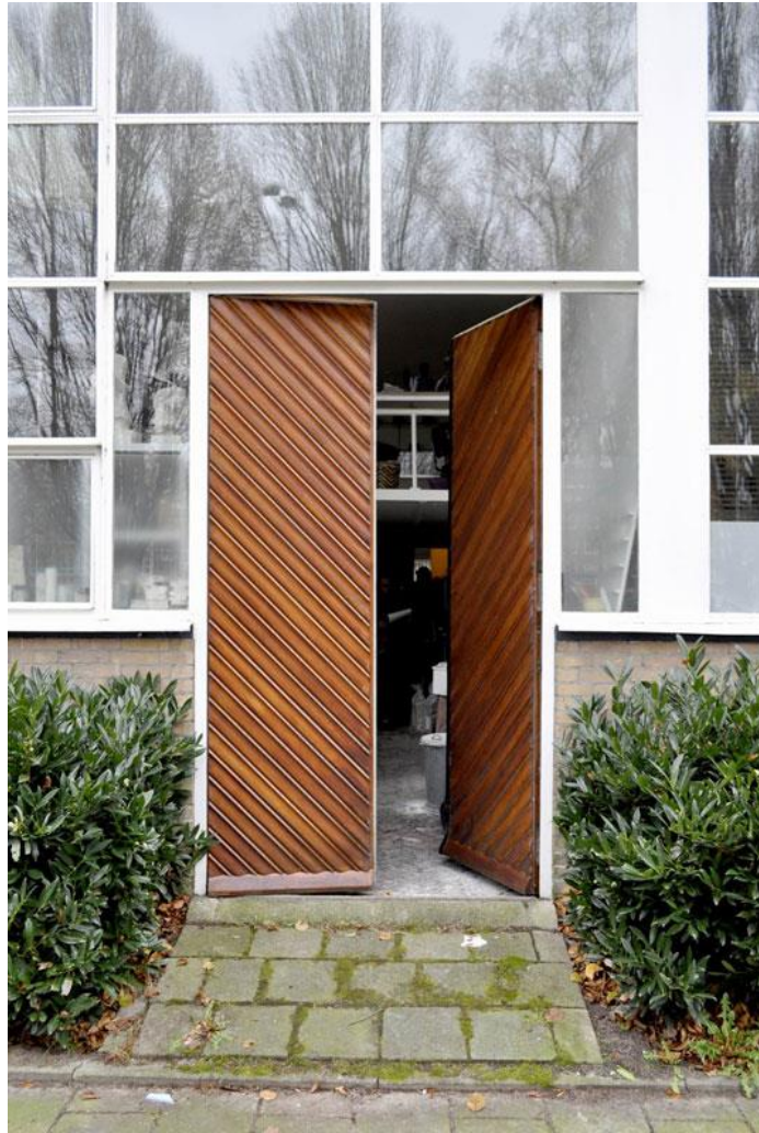
Figura 65 Puerta de acceso a viviendas convencionales en planta baja. Fuente: https://www.zuidelijkewandelweg.nl/
