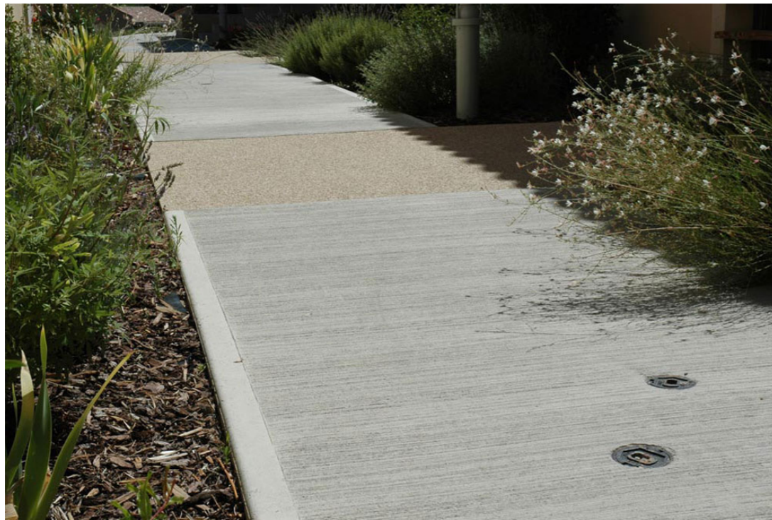
P.05/ Hormigón visto, rayado barrido.
