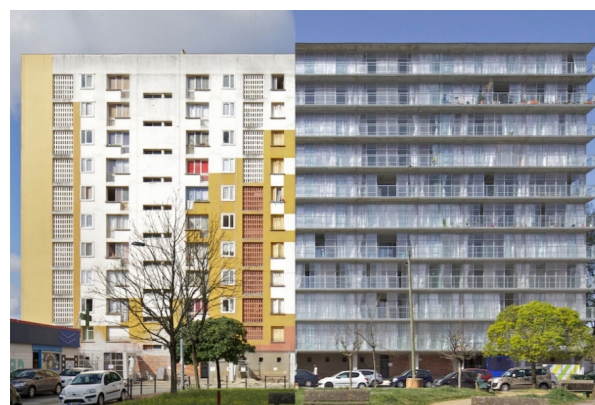
Lacaton & Vassal 530 unidades habitacionales, Bourdeaux REHABILITACIÓN FACHADA
