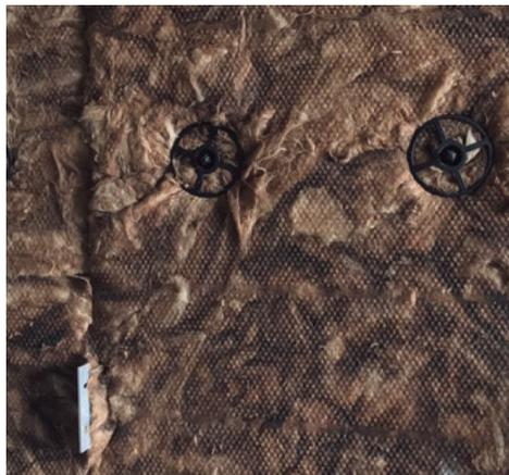
6-Destacar que cara externa de la membrana tiene un color más oscuro debido a la composición del material, es la cara con protección a los rayos UV.
