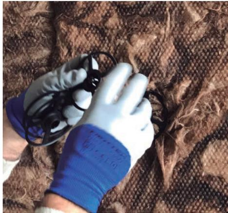
5-Se coloca la membrana impermeable cortando a la altura de la ménsula y fijándola temporalmente con un elemento de traba. Posteriormente se sujetará mediante el montante.
