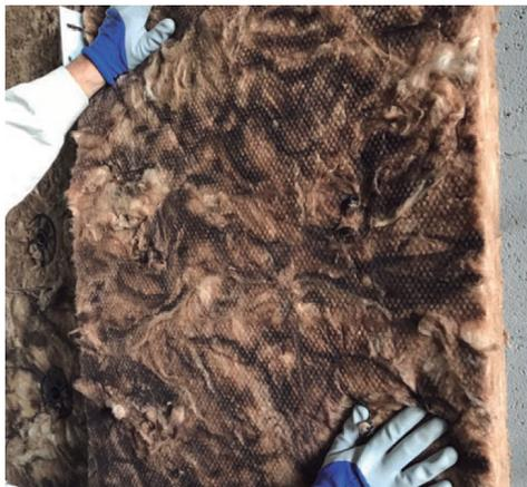
4-El diámetro del cabezal de la fijación debe tener un mínimo de 8 cm para asegurar una correcta fijación.
