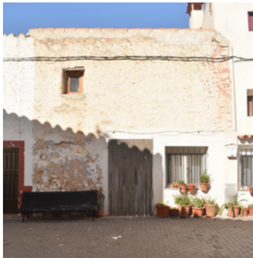
figura 33. Vivienda en La Tercia, en parte modificada.
