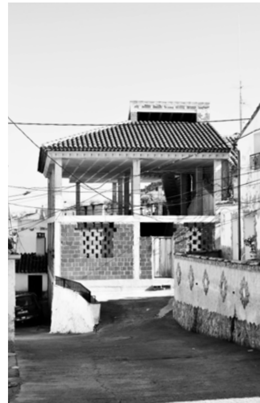
figura 74. Vivienda sin terminar en la Tercia, Benizar.
