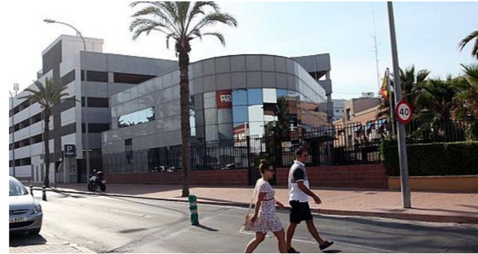
4_Edificio de la Capitanía Marítima y detrás el aparcamiento en altura para vehículos ligeros.
