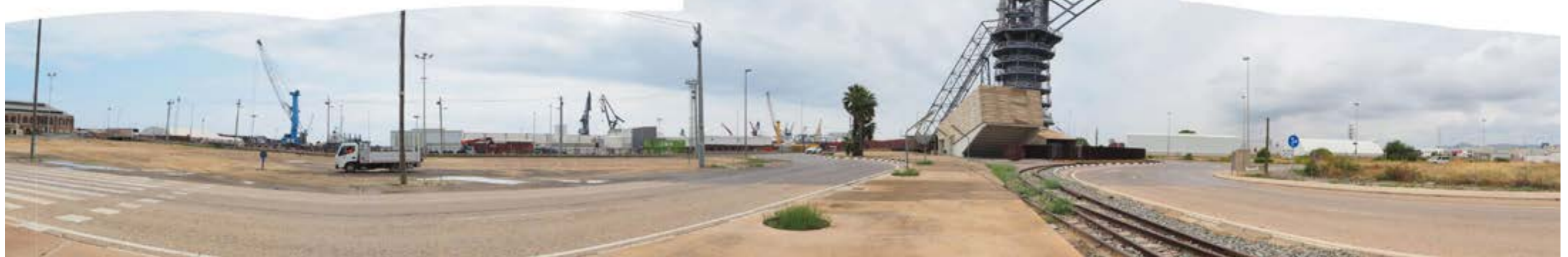
Panorámica de la explanada de los altos hornos y frente del puerto marítimo, alto horno nº2 y espacio museístico. Fuente: Propia.
