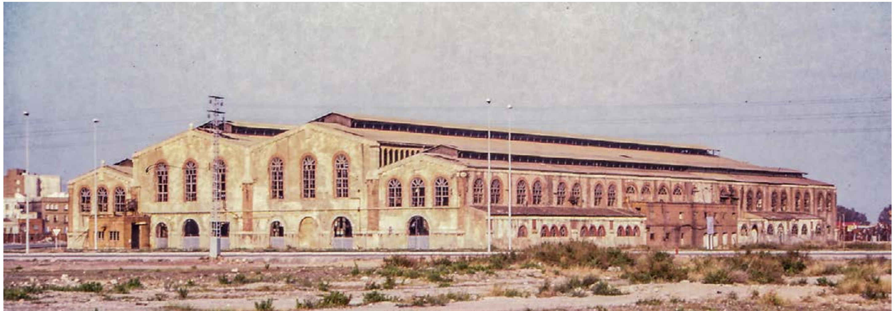
Nave de Talleres Generales en el año 2000. Fuente: Fundación de la Comunidad Valenciana de Patrimonio Industrial de Sagunto
