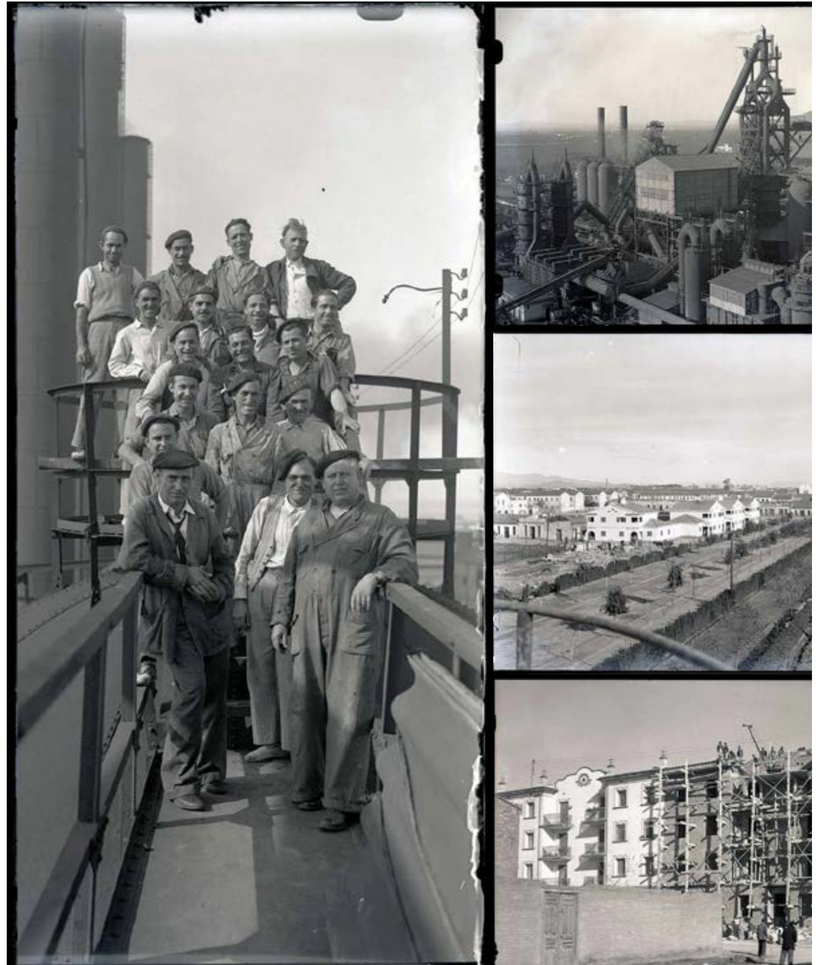
Fotos: Trabajadores en la reparación del refractario del alto horno nº3; alto horno nº2 e instalaciones anexas, vista sureste; jardines del recinto de la Gerencia; construcción grupo viviendas obreras (de izq. a der. y de arriba abajo). Fuente: Fundación de la Comunidad Valenciana de Patrimonio Industrial de Sagunto.
