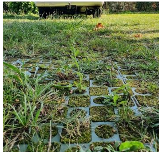
Figura 13: Ejemplo SUD: baldosas discontinuas (drenajesostenible.com)
