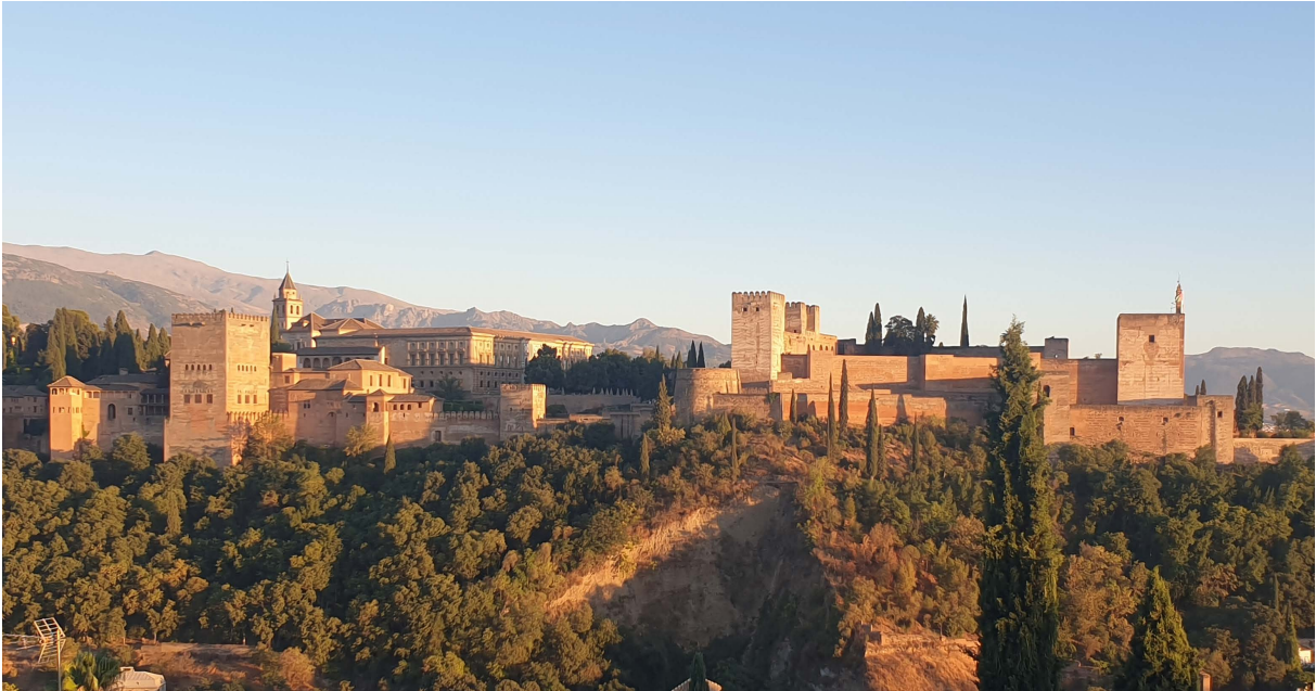
Figura 5. Fotografía de la fachada norte exterior de la Alhambra de Granada, tomada desde el mirador de San Nicolás. Se observa la alternancia de volúmenes y el aspecto másico e impenetrable del conjunto.
