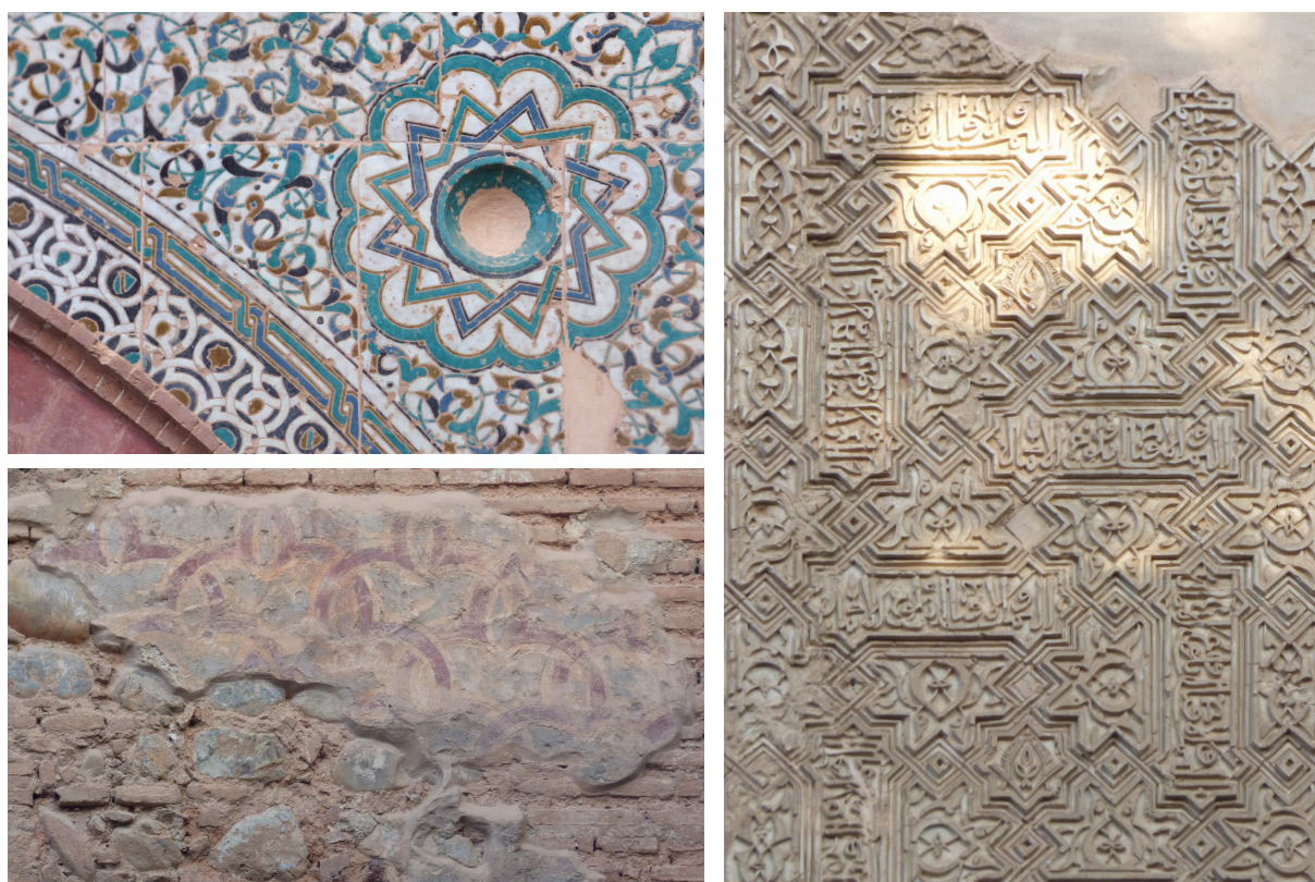
Figura 44. Detalle ornamentos de la fachada oriental de la Puerta del Vino de la Alhambra de Granada: ataurique en albanega, paño de yesería y restos de pintura sobre enlucido.
