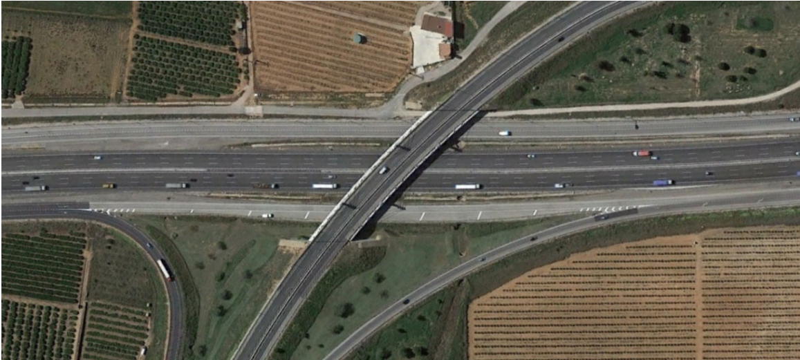
Figura 9: Zona de detención segura en una vía colectora existente con apartadero. Fuente: Google.
