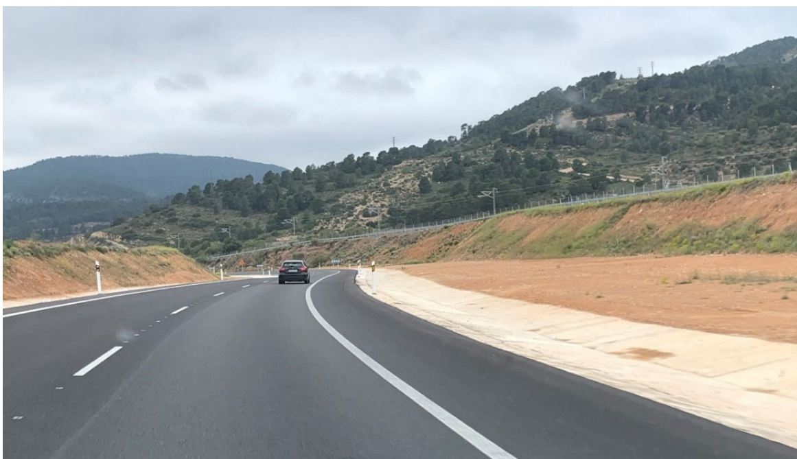
Figura 4: Apartadero exterior sobre cuneta de seguridad.
