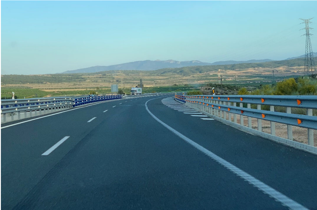
Figura 5: Apartadero exterior sobre sobrancho de estructura de paso inferior. Fuente: Google.
