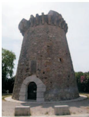
Torre de guaita de Piles.
