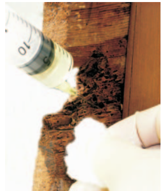
Consolidació d'un suport de fusta atacat per insectes xilòfags.
