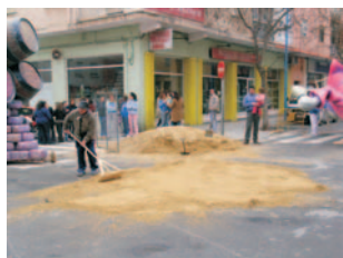
Col·locació d'un llit d'arena per a protegir el paviment.
