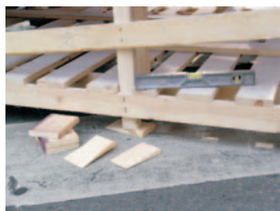
Anivellació de la peça central de la falla amb tacs i falques.
