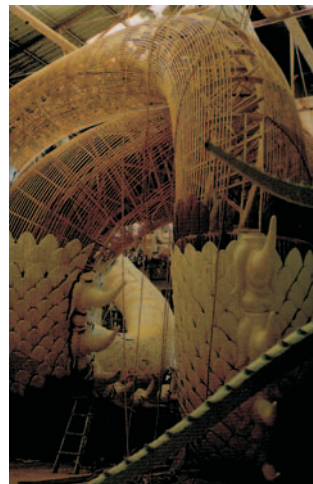
Construcció directa amb vareta.
