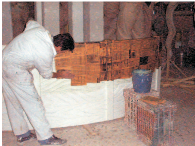
Empaperament d'una superfície de poliexpan.
