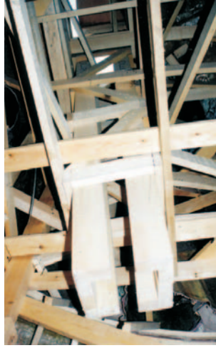
Estructura interna de fusta d'una de les peces de la falla "I tu, què pintes?" d'Alejandro Santaolalia, plantada a la plaça de l'Ajuntament de València el 2005.
