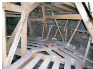
Superfície de la peça central on s'instal·laran els sacs terrers.
