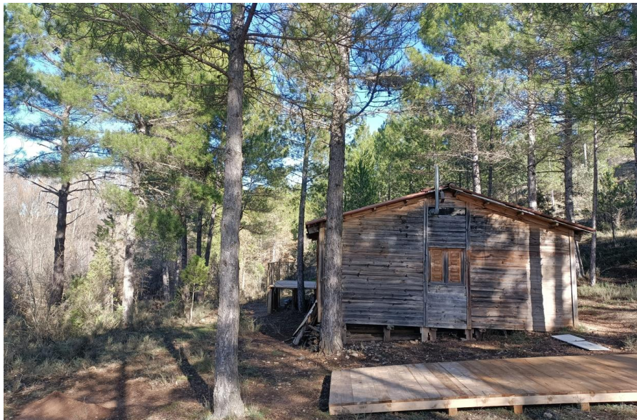
Figura 16. Detalle de la afección nº31, en Villalba de la Sierra.
