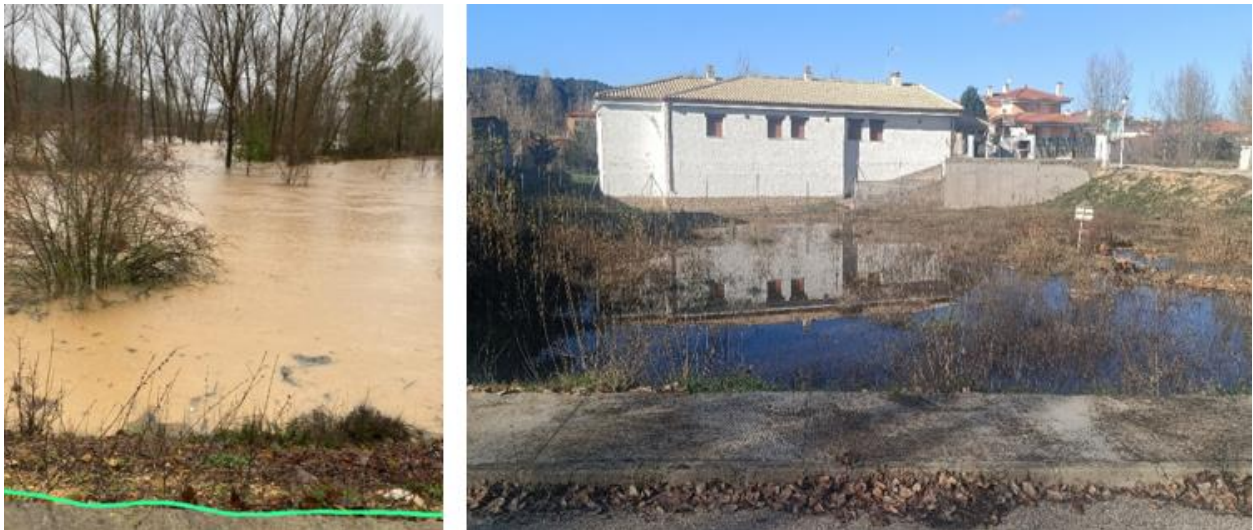
Figura 22. Detalle de la afección nº28 "Urbanización de los Perales" durante la última crecida del río Júcar.
