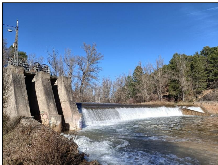
Figura 7. Azud del Molino de la Torre.
