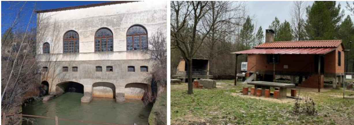
Figura 17. Detalle de las afecciones nº43 y nº50.
