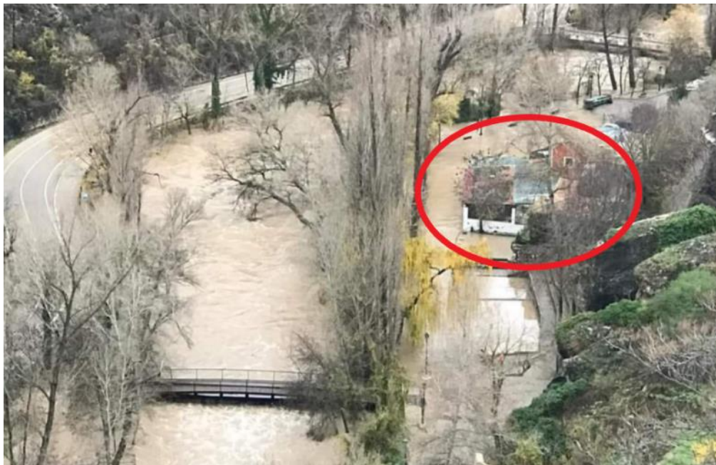
Figura 18. Detalle de la afección nº62 durante la avenida del 13/12/2022
