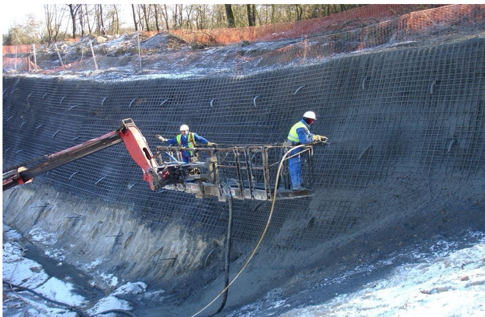
Figura 19. Operarios realizando el proyectado del hormigón. Fuente: perfotalud.com.
