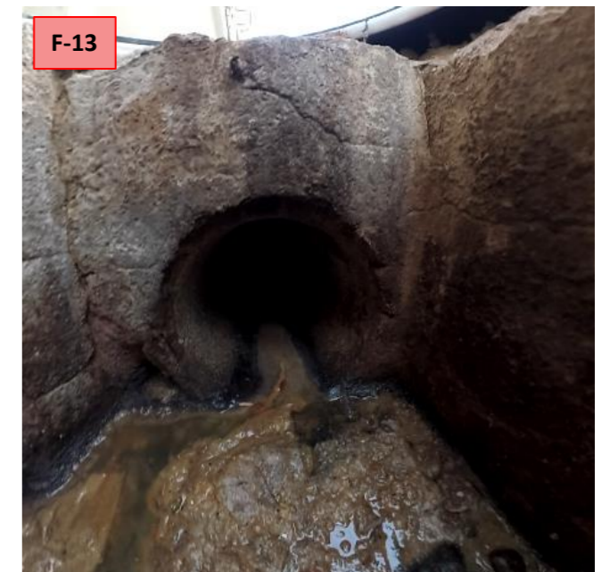
P-32020. Cabecera del colector secundario ramal derecho que vierte a la calle Tres Forques.
