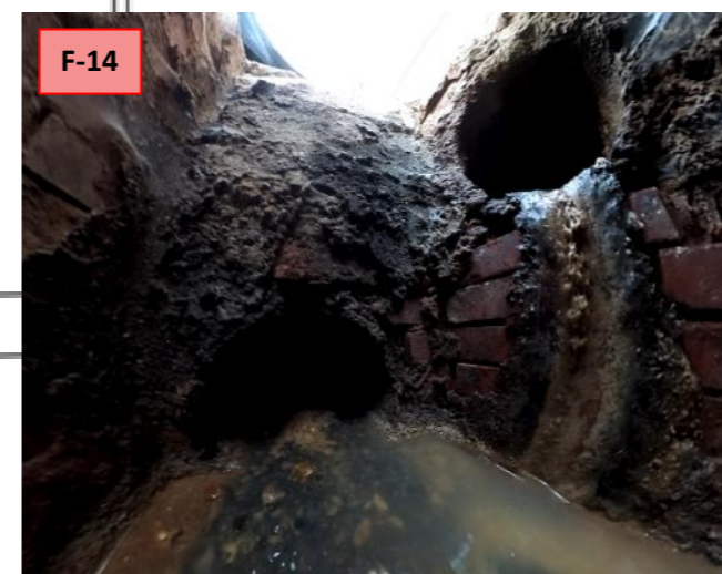
P-9985. Pozo final del colector secundario ramal derecho que vierte a la calle Tres Forques. Ambos ramales desembocan en el mismo pozo.
