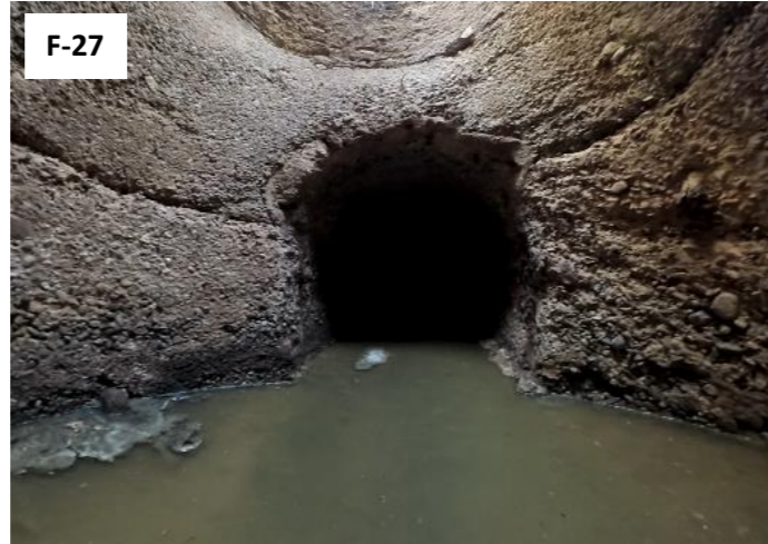
P-40068. Colector principal de Tres Forques cuya sección es un cajero de 1,10x0,70 m. Profundidad > 2,50 m.
