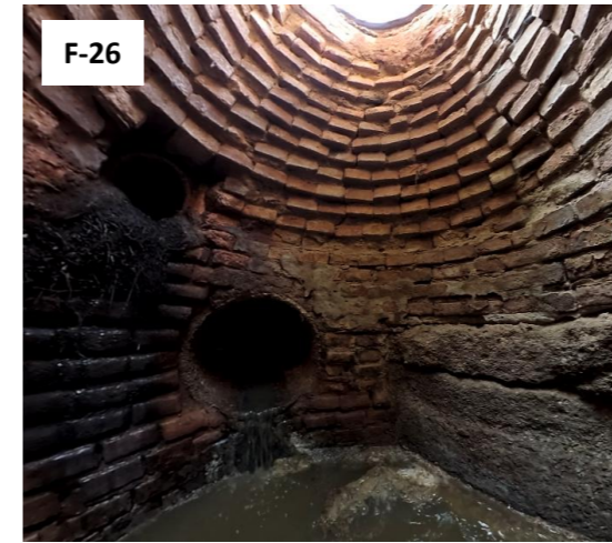
P-12679. Colector principal en el que vierten las aguas de los colectores de las calles Guillem Despuig y Norman Bethune. Profundidad > 2 m.
