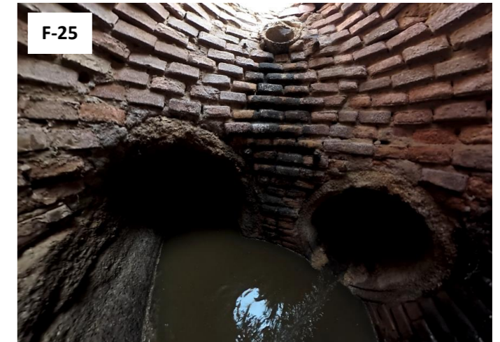
P-12679. Colector principal en el que vierten las aguas de los colectores de las calles Guillem Despuig y Norman Bethune. Profundidad > 2 m.
