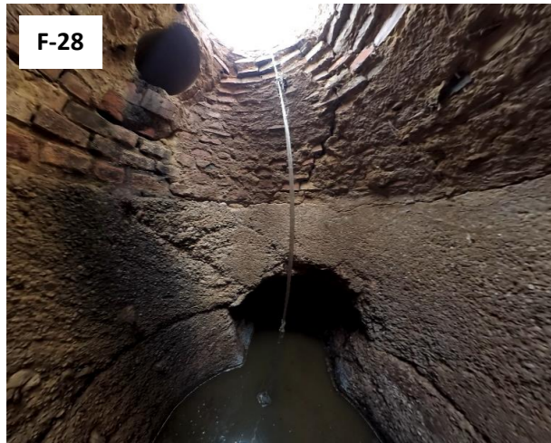
P-40068. Colector principal de Tres Forques cuya sección es un cajero de 1,10x0,70 m. Profundidad > 2,50 m.
