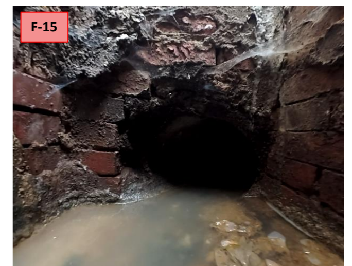
P-9985. Pozo final del colector secundario ramal derecho que vierte a la calle Tres Forques. Ambos ramales desembocan en el mismo pozo.
