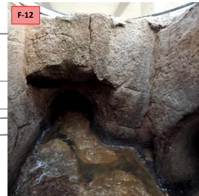
P-32020. Cabecera del colector secundario ramal derecho que vierte a la calle Tres Forques.
