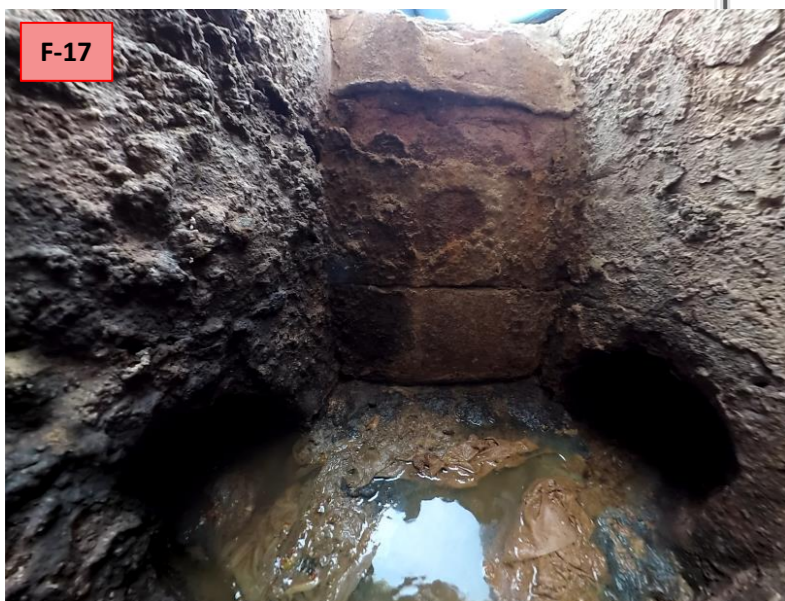
P-9196. Pozo final del colector secundario ramal izquierdo que vierte a la calle Tres Forques.
