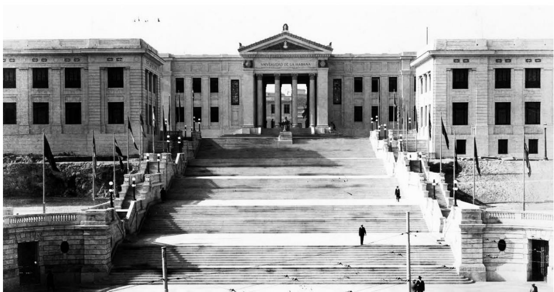
Dos fotografías durante proceso de construcción, y ya terminada y ornamentada con banderas de los distintos países que representaron al VI Congreso Panamericano que se celebró en sus facilidades. Secretaría de Obras Públicas - Negociado de Construcciones Civiles y Militares, La Habana, 1927.
