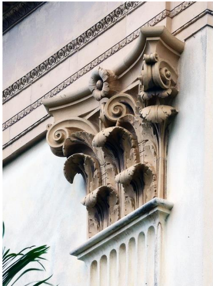
Detalles ornamentales de las pilastras de piedra artificial moldeada. Fotos por Pantel del Cueto LLC, 2018.
