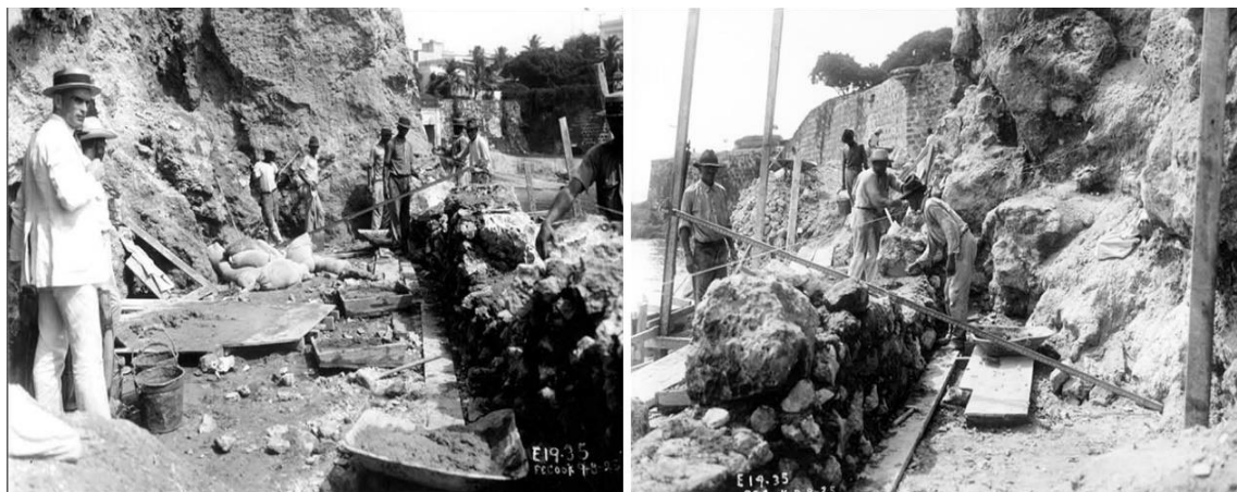
Obreros en San Juan, Puerto Rico utilizando cemento Pórtland para reparar murallas históricas de la ciudad, 1935. Archivo Histórico del San Juan National Historic Site, Puerto Rico.
