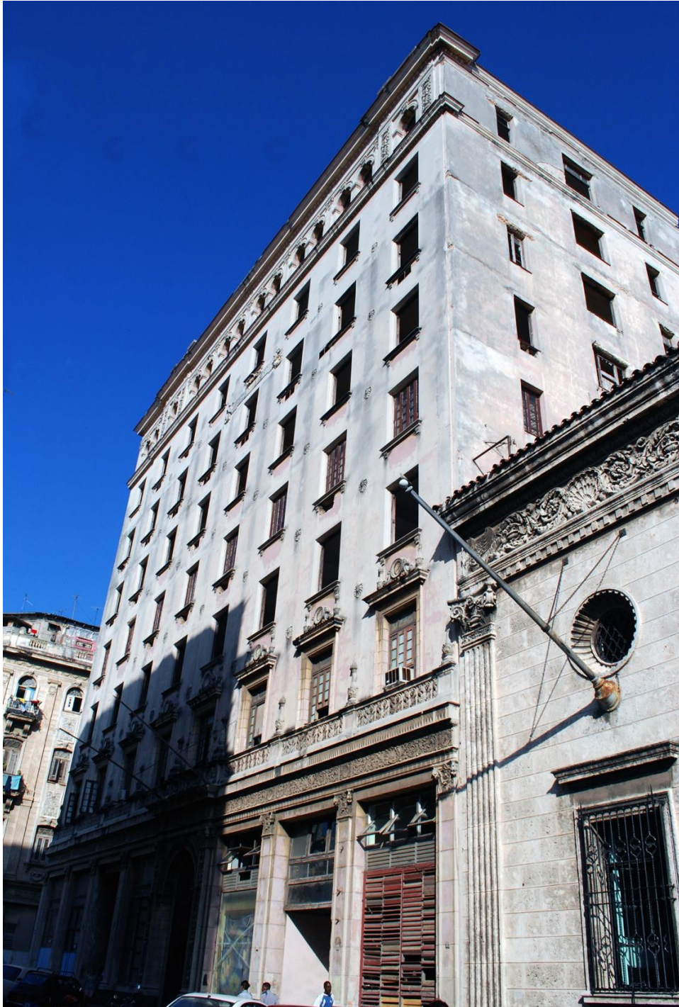
Edificio de oficinas La Metropolitana. Foto por Pantel del Cueto & Asociados LLC, 2018.
