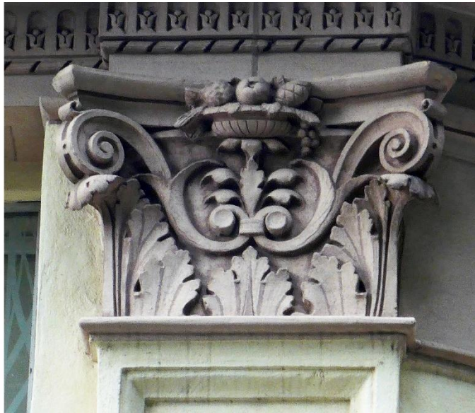
Detalles ornamentales de las pilastras de piedra artificial moldeada. Fotos por Pantel del Cueto LLC, 2018.
