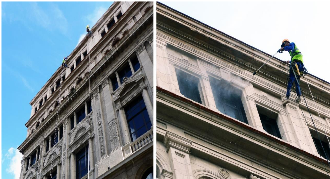
Mantenimiento y limpieza con agua a presión de la Lonja. Fotos por Pantel del Cueto & Asociados LLC, 2018.
