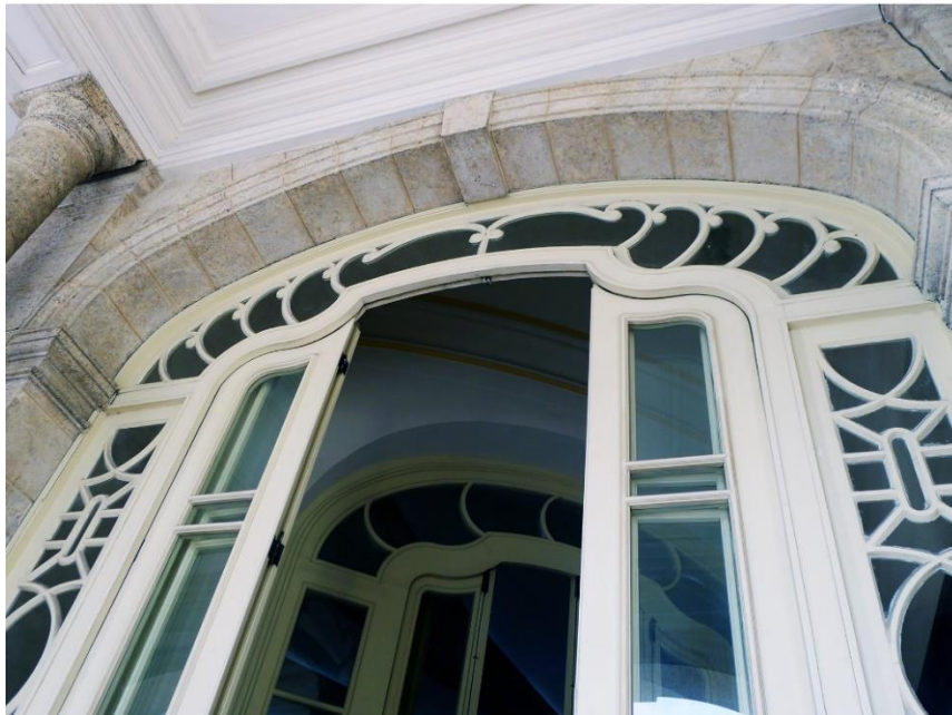
Tragaluz de la escalinata principal hacia espacios de recepción y puertas ventanas del segundo piso. Fotos por Pantel del Cueto LLC, 2018.
