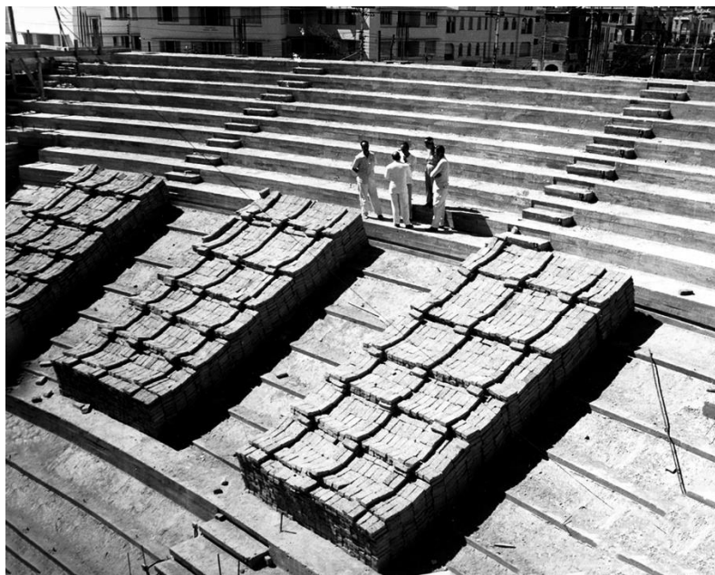
Ladrillos para la construcción de las gradas en el teatro principal de Radiocentro en La Habana. Fototeca, Archivo Nacional de Cuba, 1947-49.
