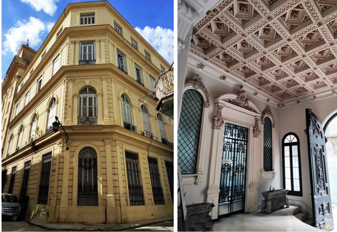
Tres fachadas del edificio National Trust con su chanfle, una esquina urbana en La Habana donde los cuatro edificios de esta intersección son todos achafanados. Ornamentación elaborada de entrada principal elevada. Cortesía de la historiadora licenciada Yamira Rodríguez Marcano, 2022.
