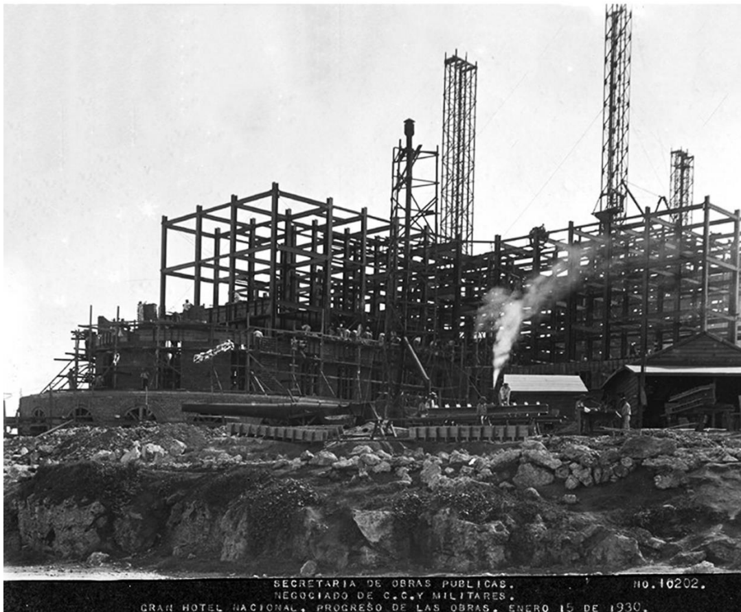
Gran Hotel Nacional - construcción de estructura acero, 1929-1930. Secretaría de Obras Públicas - Negociado de Construcciones Civiles y Militares, La Habana, 1929.
