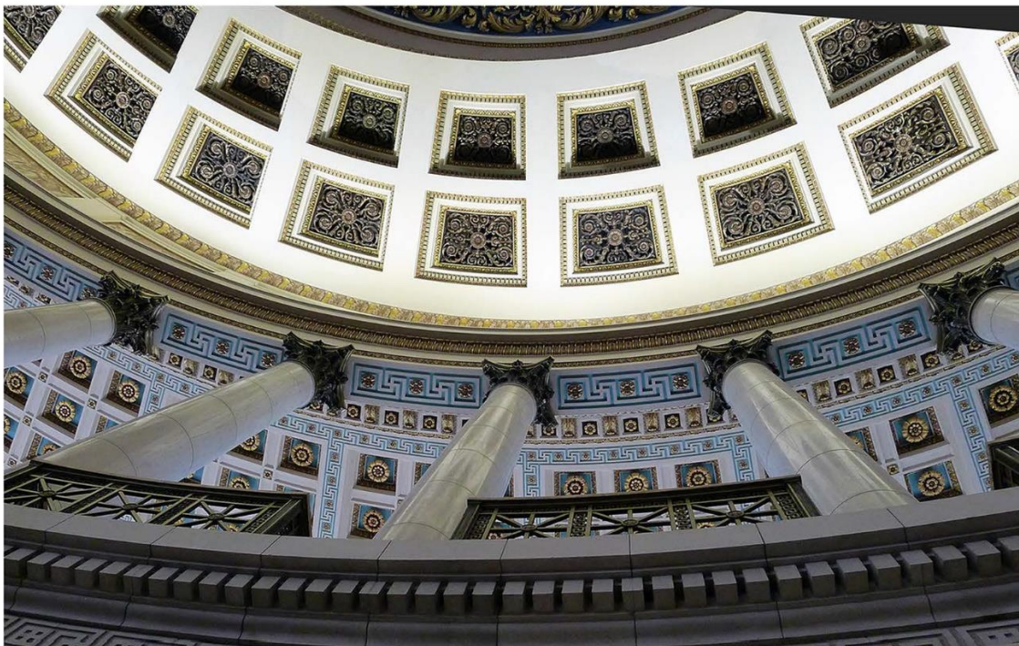
Vistas del interior del cielo raso de la cúpula, foto parcial de los pasos perdidos, y detalle del interior columnado del cielo raso de la cúpula. Fotos por Pantel del Cueto LLC, 2018.
