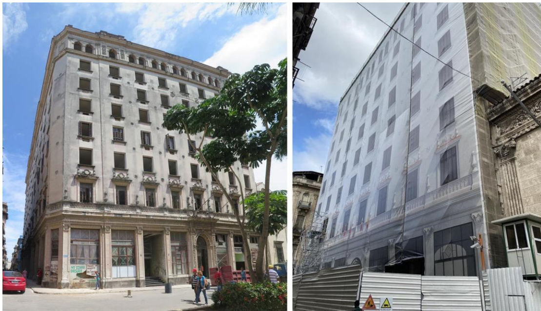
La Metropolitana antes de intervenir y durante proceso de rehabilitación para convertirlo en el Hotel Metrópolis. Empresa RESTAURA, Oficina del Historiador de La Habana, 2015-2022.
