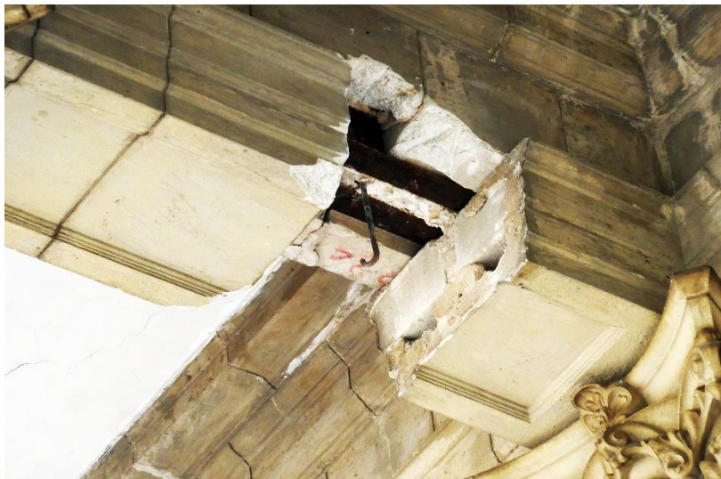
Detalles de piedra artificial moldeada en el cielo raso del portal de entrada al antiguo banco, donde se pueden apreciar segmentos de este material edilicio. Fotos por Pantel del Cueto LLC.
