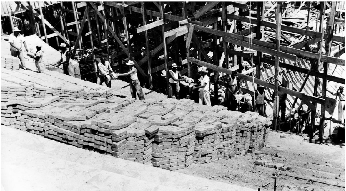
Ladrillos para la construcción de las gradas en el teatro principal de Radiocentro en La Habana. Fototeca, Archivo Nacional de Cuba, 1947-49.
