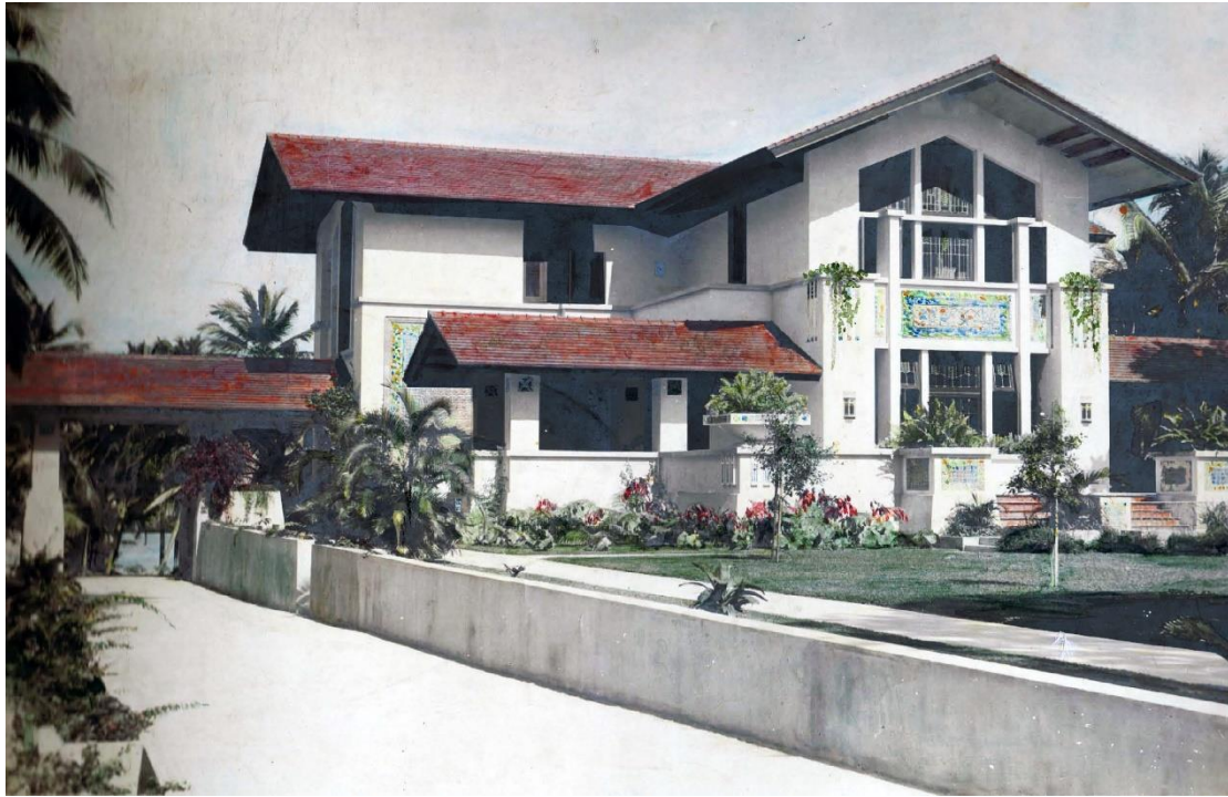
Foto coloreada de la casa Korber en San Juan, Puerto Rico diseñada por el arquitecto Antonín Nechodoma y edificada por Frank B. Hatch en hormigón armado durante 1916. Colección privada de documentos históricos de Nechodoma del Arq. Otto O. Reyes Casanova, San Juan.
