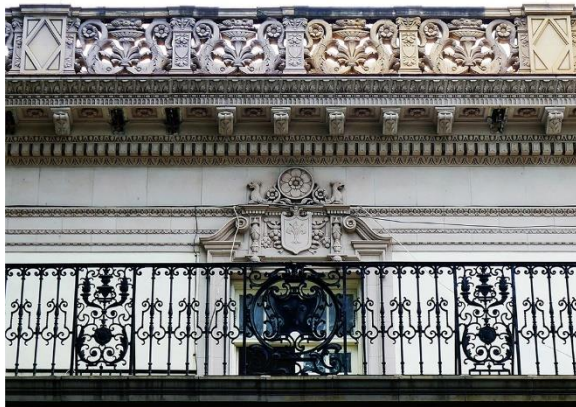
Fachada posterior de la residencia con vista de los detalles de su método de construcción con piedra artificial moldeada claramente visible con sus correspondientes anclajes de hierro. Fotos por Pantel del Cueto LLC, 2018.
