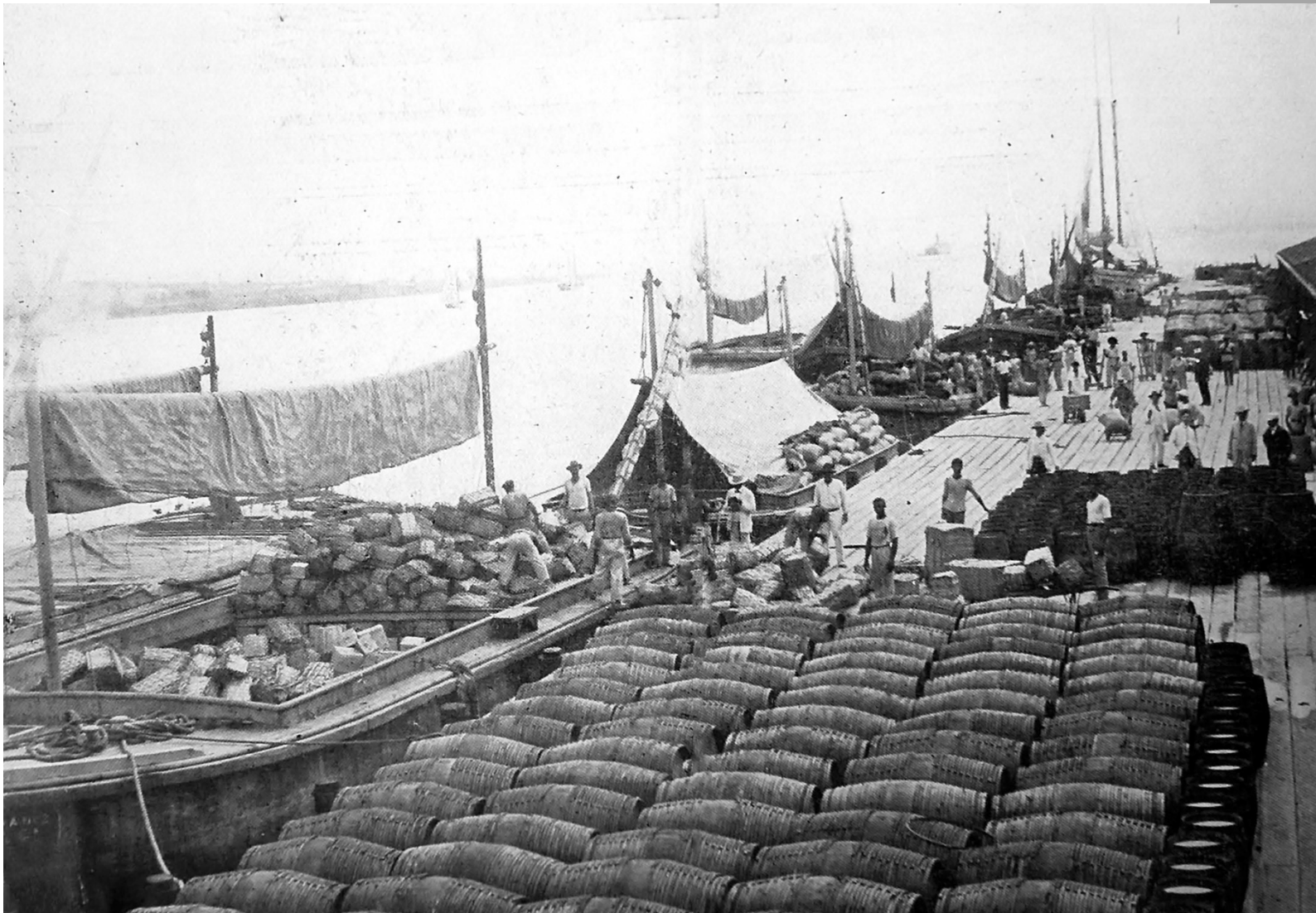
Muelle en el puerto de San Pedro de Macorís en la República Dominicana y barriles con cemento Pórtland marca Alpha importado desde E.E. U.U. Penson, Enrique. Arquitectura Dominicana 1906-1950 , Santo Domingo: Mediabyte, S.A., 2005; y Album del Centenario de la República Dominicana . La Habana: Artes Gráficas, S.A., 1936.
