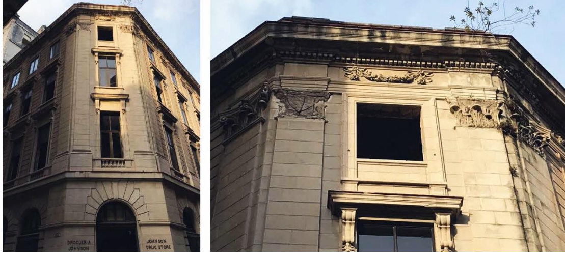
Superficies exteriores de la Droguería Johnson antes de intervención, 2018. Interiores restaurados en función y como Museo de la Farmacia. Fotos por Pantel del Cueto & Asociados LLC, 2018.
