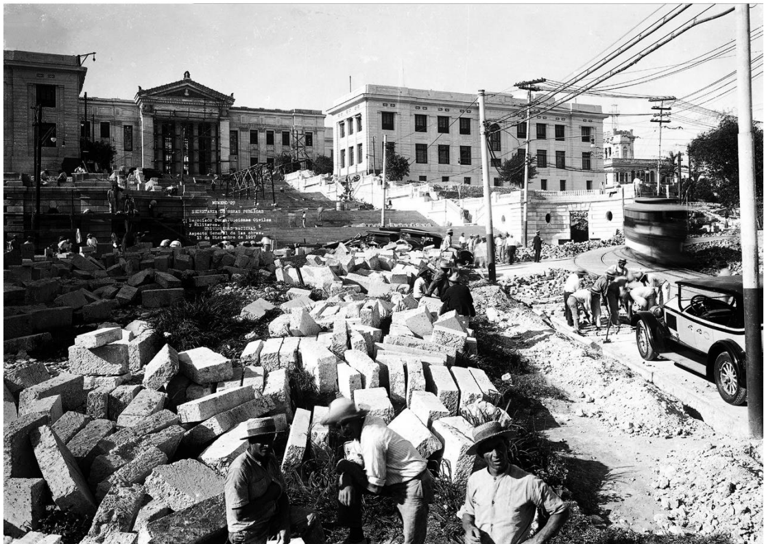
Ubicación de la Universidad de La Habana en área alta de la ciudad sin escalera de entrada, y durante el proceso de construcción trabajando el mármol para cubrir los escalones. Secretaría de Obras Públicas - Negociado de Construcciones Civiles y Militares, La Habana, 1927.
