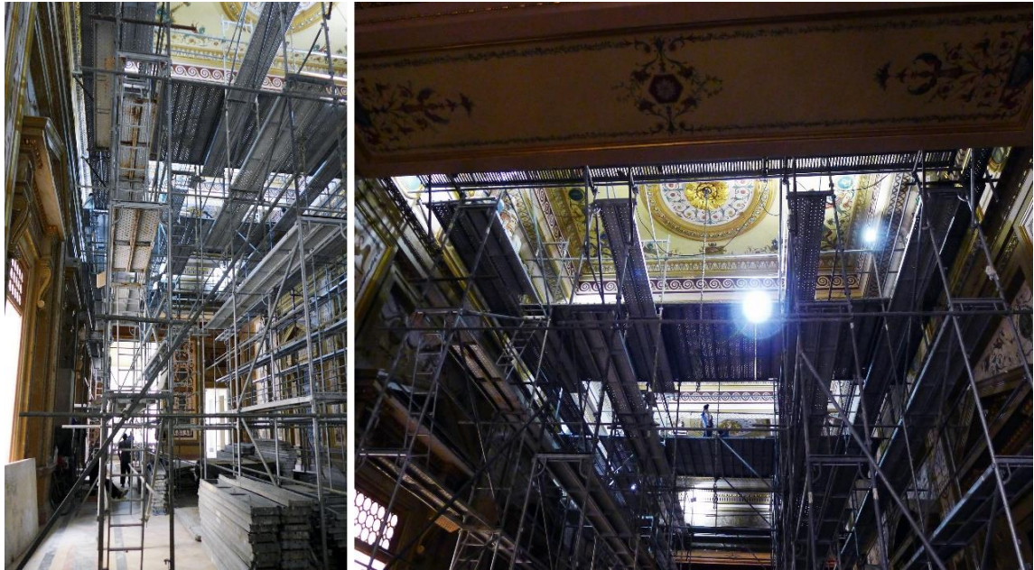
Andamios interiores durante obras de restauración del Capitolio. Fotos por Pantel del Cueto & Asociados LLC, 2018.
