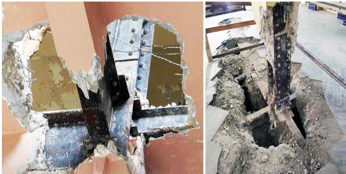
Condición existente de elementos interiores de acero históricos recubiertos con hormigón en del antiguo banco. Fotos por Pantel del Cueto & Asociados LLC, 2018.
