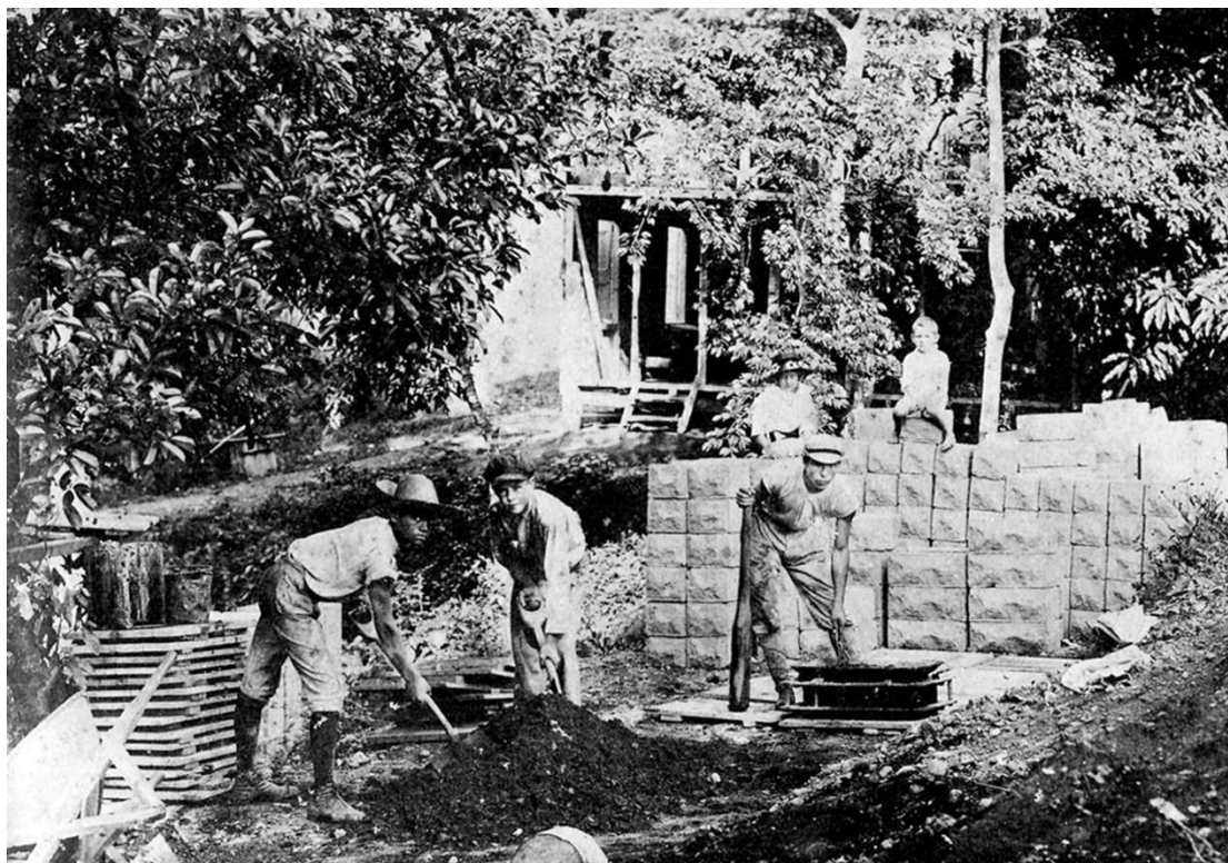
Los bloques de hormigón más tempranos se fabricaban individualmente en la misma obra. Colección Museo William Harris, Riding and Roping: The Memoirs of J. Will Harris . Maryland, Port City Press. Universidad Politécnica de San Germán, Puerto Rico, 1910.
