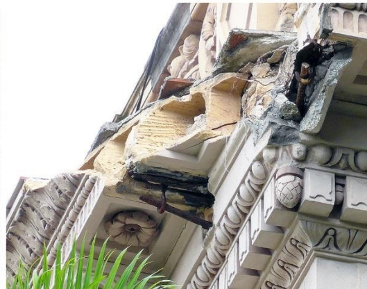
Fachada posterior de la residencia con vista de los detalles de su método de construcción con piedra artificial moldeada claramente visible con sus correspondientes anclajes de hierro. Fotos por Pantel del Cueto LLC, 2018.
