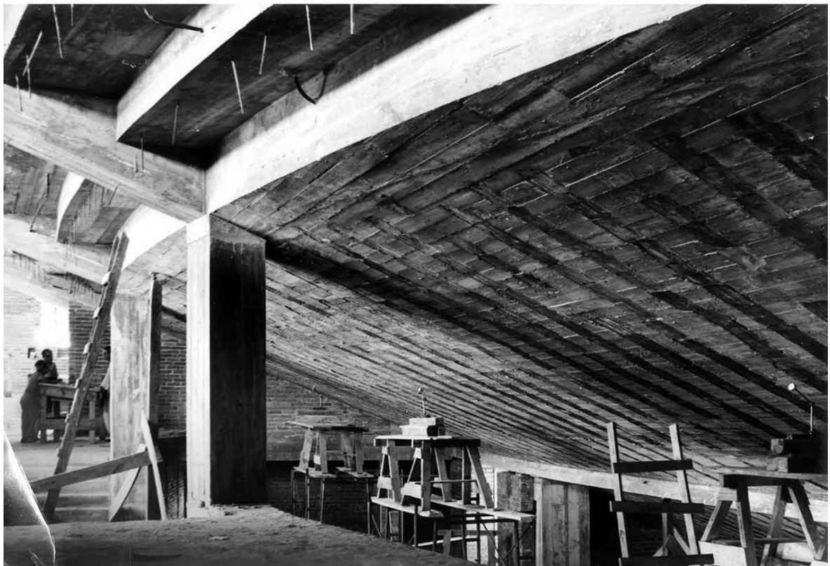
Ladrillos para la construcción de las gradas en el teatro principal de Radiocentro en La Habana. Fototeca, Archivo Nacional de Cuba, 1947-49.
