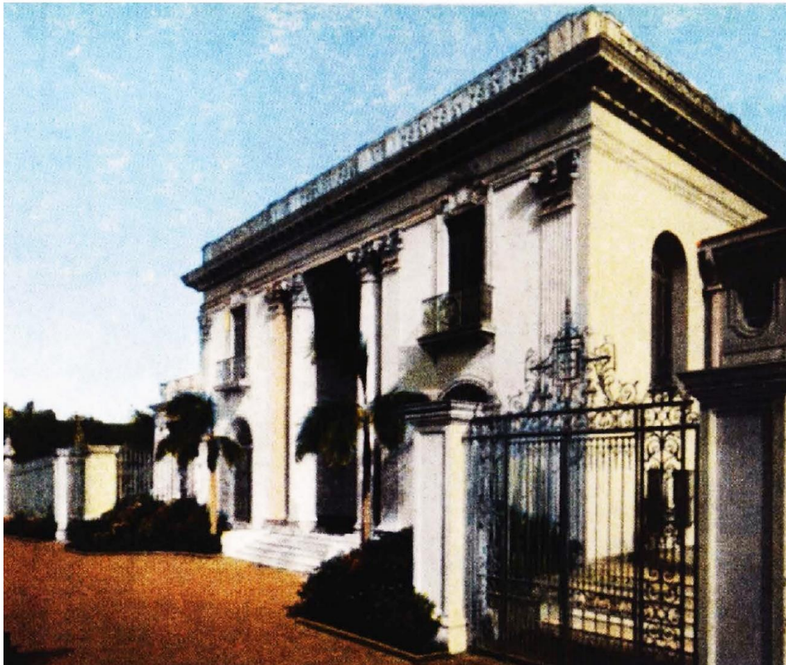
Varias vistas de las fachadas frontal y posterior de la residencia ubicada en el prestigioso barrio de El Vedado, diseñada por el reconocido arquitecto de Nueva York Thomas Hastings (de la firma de Carrere & Hastings, diseñadores de la Biblioteca Pública de N.Y.) Revista Social , septiembre 1930.
