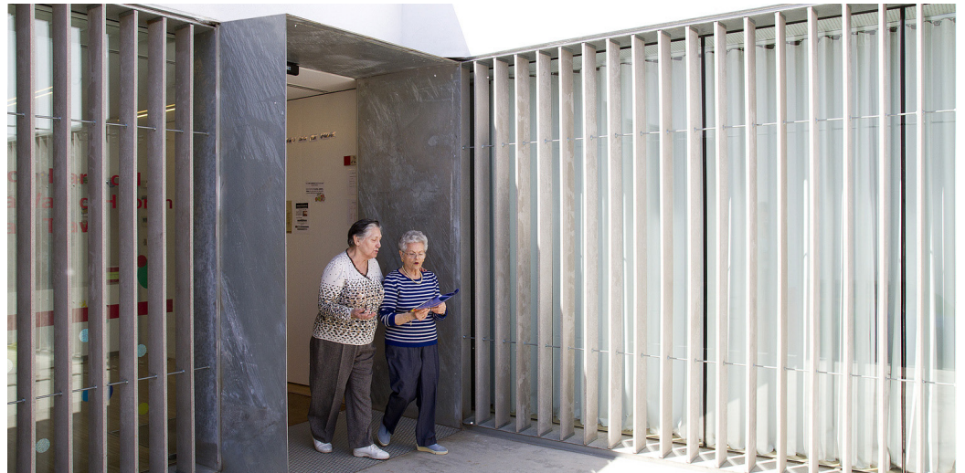
Fig. 26. Sistema de lamas. (Fuente: Archdaily)
