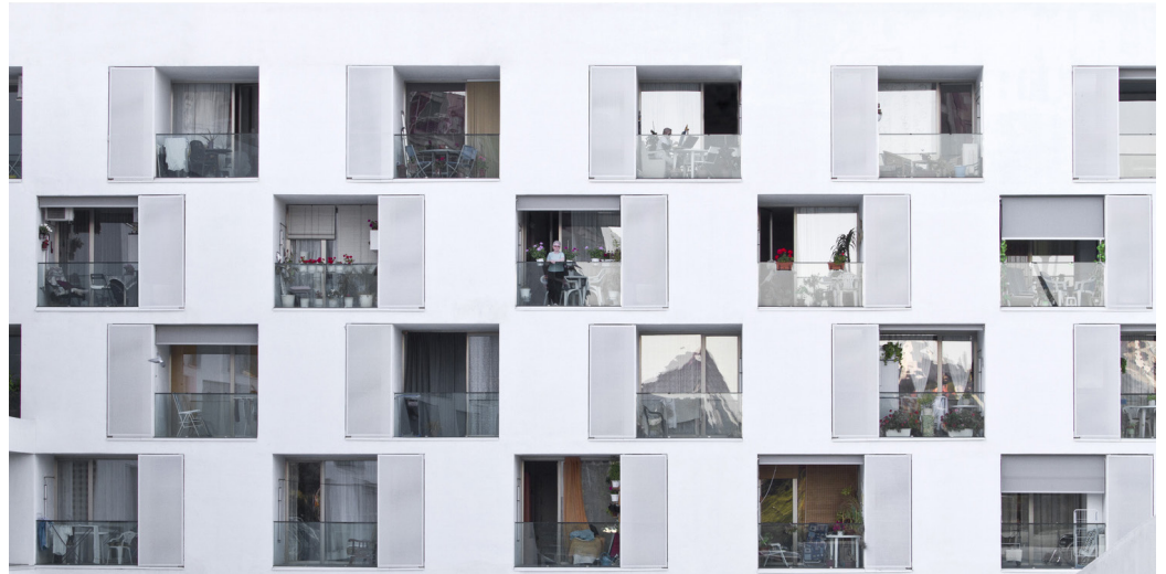
Fig. 27. Fachada y terrazas, comunicación social. (Fuente: Archdaily)
