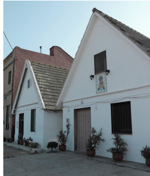
Fig 58. Barraca en Castellar-Oliveral. Fuente: Arquitectura valenciana tradicional: una adaptación de la barraca a la vida contemporánea, TFG, Ramos Furió, Cristina (2018)
