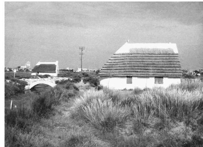
Fig 93. Cabaña en el Pont du Mort. Fuente: https://www.leslaunes.com
