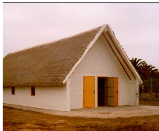
Fig 72. Barraca de la Casa de Fusta. Fuente: Escola Taller Baladre
