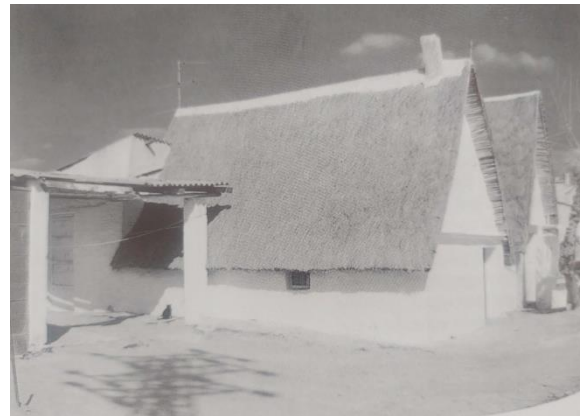
Fig 31. Las Barracas de Burra en Valencia, vista de 1997. Fuente: Arquitectura rural Valenciana: tipos de casas dispersas y análisis de su arquitectura.
