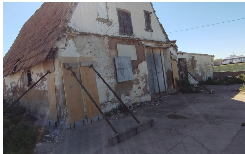
Fig 122. Apuntalamiento frontal fachada oeste Fuente: Carlos Fuster Aparisi
