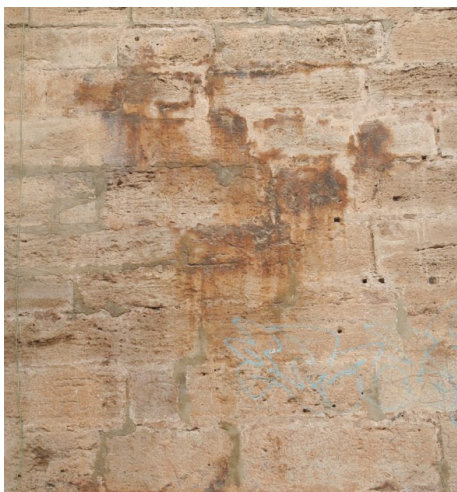
Figura 7.7. Material pétreo Tosca de Rocafort. Tinción por óxidos de hierro.
