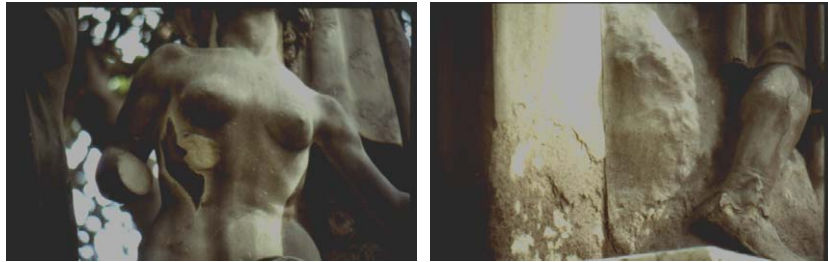
Figura 7.10. Material pétreo Bateig Crema. Pérdida de material pétreo. Costras.
