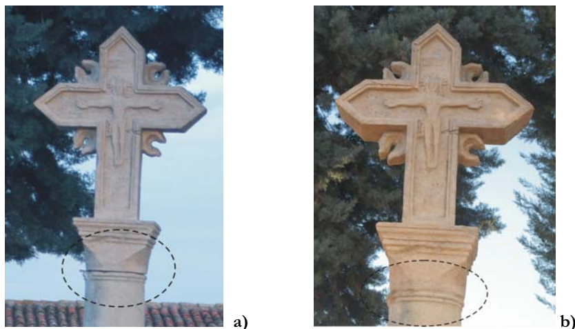
Figura 12.3. Intervención de sellado. a) Antes y b) después. Uniformidad visual.
