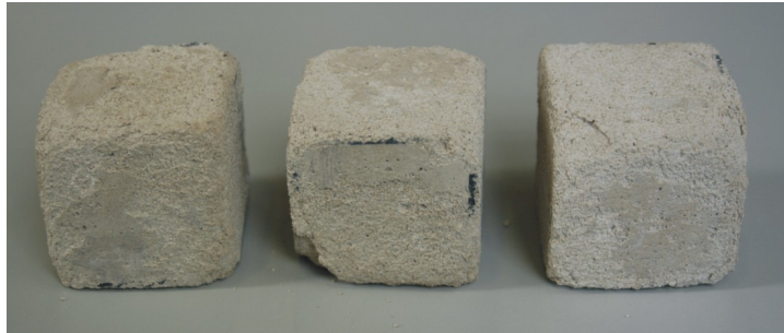
Figura 11.25. Probetas de mortero cal-yeso (MN) Bateig Crema al finalizar los ciclos de cristalización de sales (ciclo n° 15). Se observa la presencia de desagregación granular, desmoronamiento, etc.
