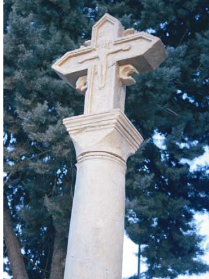
Figura 12.17. Montaje de la réplica sobre la columna.
