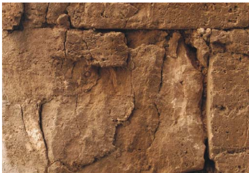
Figura 7.12. Material pétreo Tosca de Rocafort. Disyunción.
