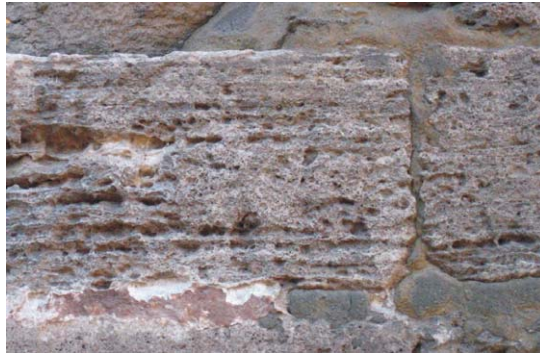
Figura 7.5. Material pétreo Tosca de Rocafort. Acanalación.
