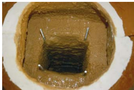
Figura 12.14. Tercera capa cubriendo la junta de separación de las membranas de elastómero.
