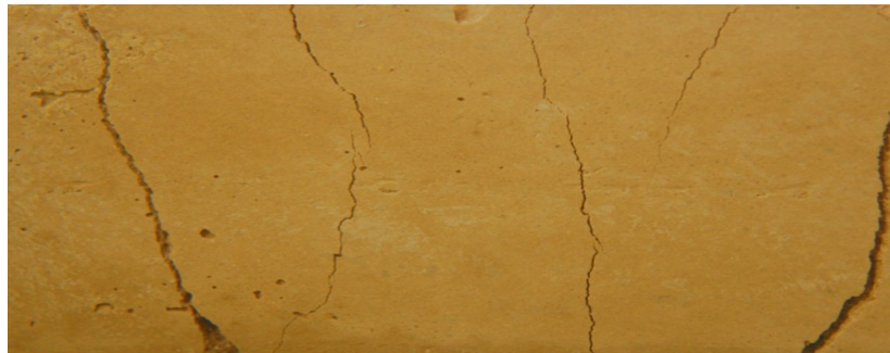
Figura 11.12. Mortero acrílico Tosca de Rocafort tras el ensayo de compresión. Presencia de grietas por las cargas a compresión ejercidas sobre la probeta.
