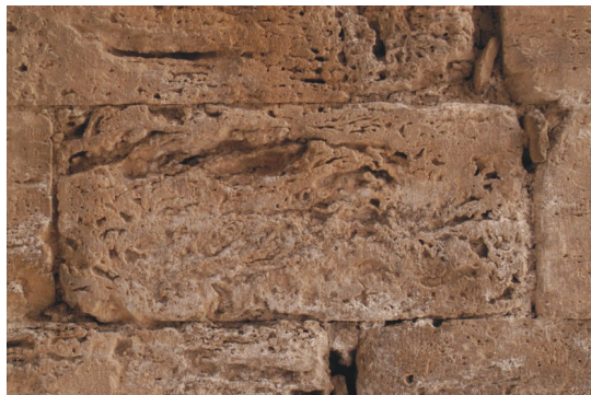
Figura 7.6. Material pétreo Tosca de Rocafort. Vermiculación.
