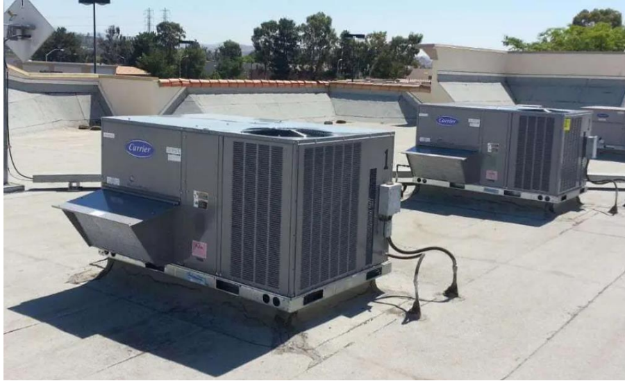
Ilustración 17. Fotografía de una unidad Rooftop.
