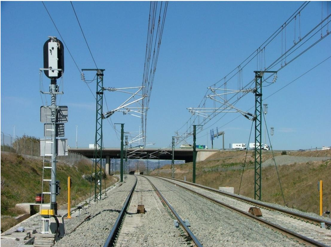
*Figura 2. Imagen de la catenaria en una red española de ferrocarriles extraída de Wikipedia*
