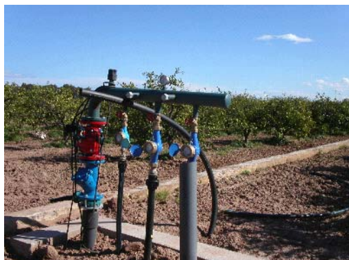
FIGURA 2. INSTALACIÓN TÍPICA DE UN HIDRANTE DE RIEGO.
