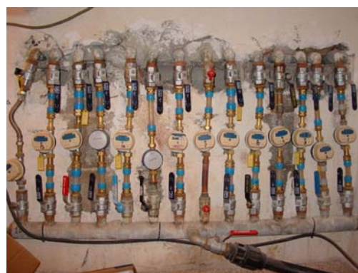
FIGURA 3. BATERÍA DE CONTADORES DOMÉSTICOS INSTALADOS EN POSICIÓN VERTICAL.
