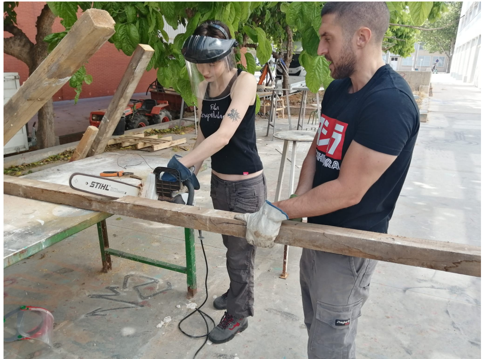
Fig. 10 Proceso de construcción de la barrera. 2023
