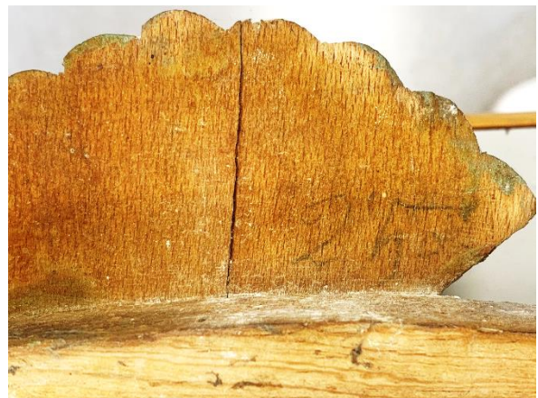
Figura 92. Detalle de la grieta en el anverso del marco.
