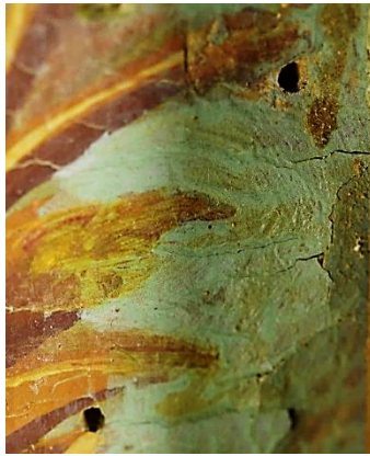
Figura 81. Orificios provocados por los insectos xilófagos.
