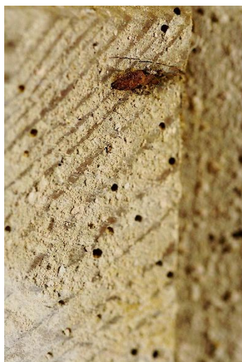
Figura 63. Detalle del ataque de insectos xilófagos en el travesaño.
