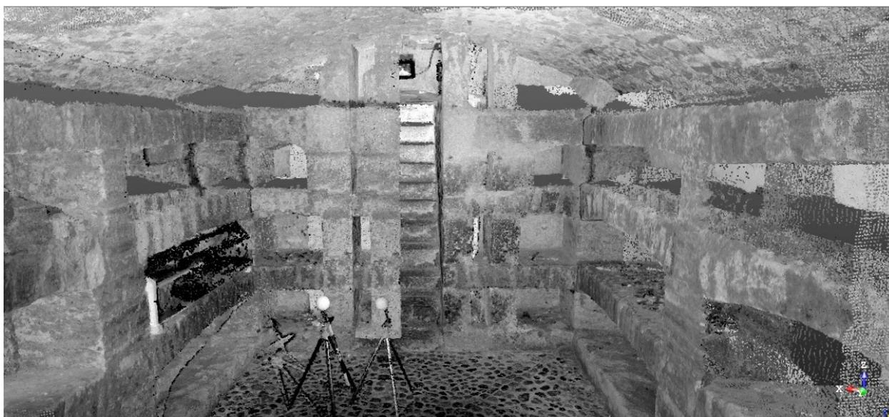
*Nota:* Nube de puntos de las catacumbas de la Iglesia Nuestra Señora de las Nieves de Sicalpa Viejo, levantada con escáner FARO Focus Láser 3D y depurada con programa software Trimble Real Works.
