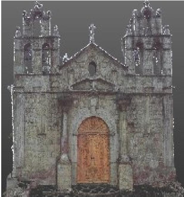
*Nota:* Nube de puntos a color de la portada principal de la Iglesia Sicalpa Viejo, levantada con escáner FARO Focus Láser 3D y depurada con programa software Trimble Real Works.
