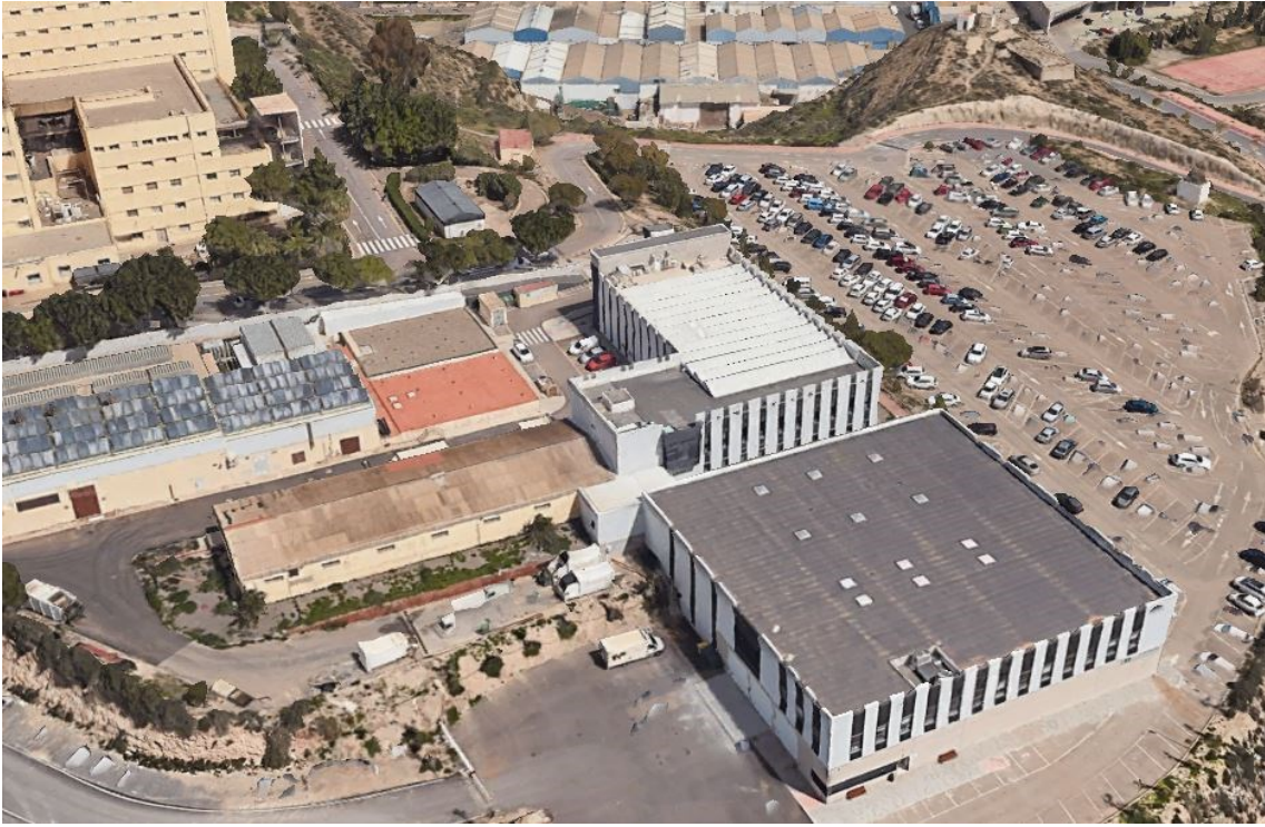
Ilustración 12 Vista Oeste Cubiertas Almacén y Laboratorio Fuente: Google Earth
