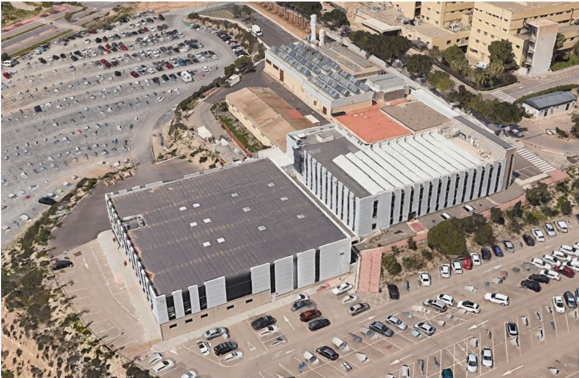
Ilustración 13 Vista Este Cubiertas Almacén y Laboratorio Fuente: Google Earth
