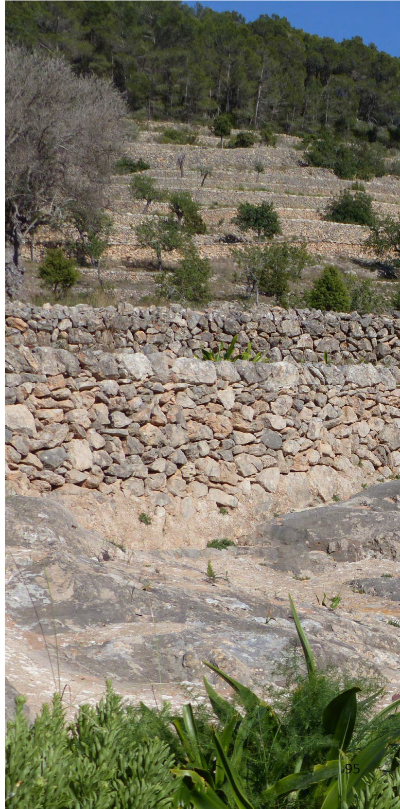
Fig. 85. Can Racó. "Cultiu en feixes". El terreno rocoso que se observa en la parte inferior de la fotografía sirve para recoger el agua de lluvia y canalizarla al "aljub".
